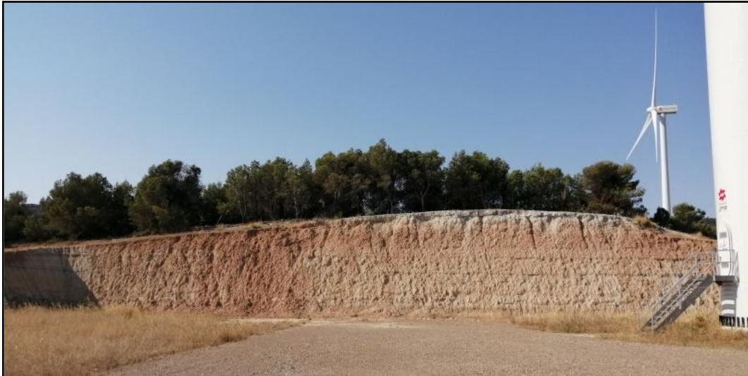
Fotografía 3. Desmonte desprovisto de vegetación.
