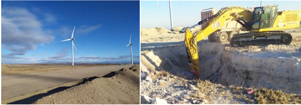
Foto 25. Plataforma 3 terminada ya durante la segunda visita de revisión ambiental, y comienzo de excavación del foso de la cimentación 3 (18/11/2022).
