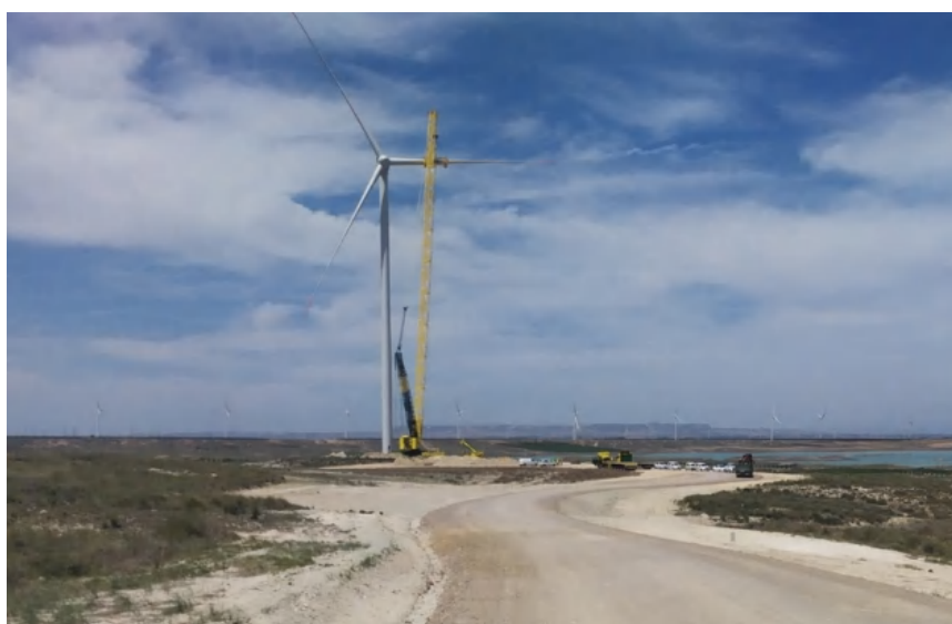
Foto 36. Ensamblaje de la última pala del aerogenerador 1 (Visita del 16/05/2022).
