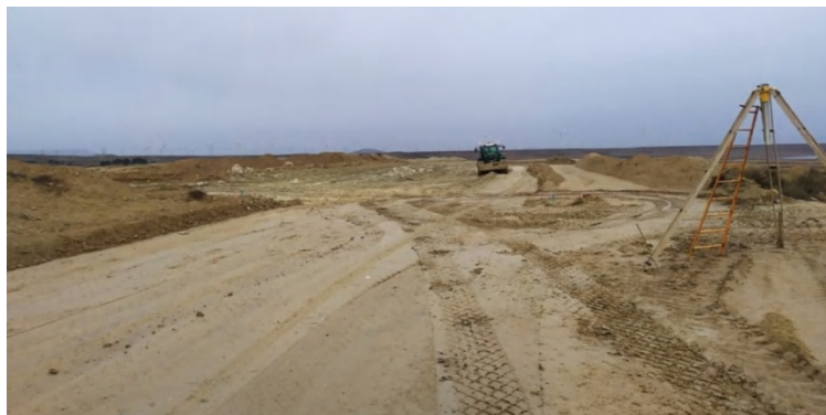
Foto 27. Nivelado de la plataforma del aerogenerador 1 (9/12/2021).
