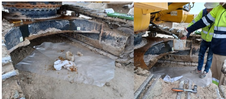
Foto 12. Fuga de aceite de uno de los vehículos de obra siendo limpiado y retirado de la zona de obra (21/12/2021).
