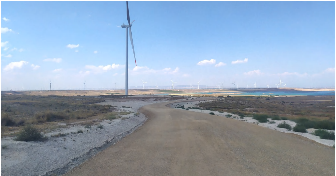
Foto 48. Vial de acceso al aerogenerador 1, con sus taludes restaurados con tierra vegetal.
