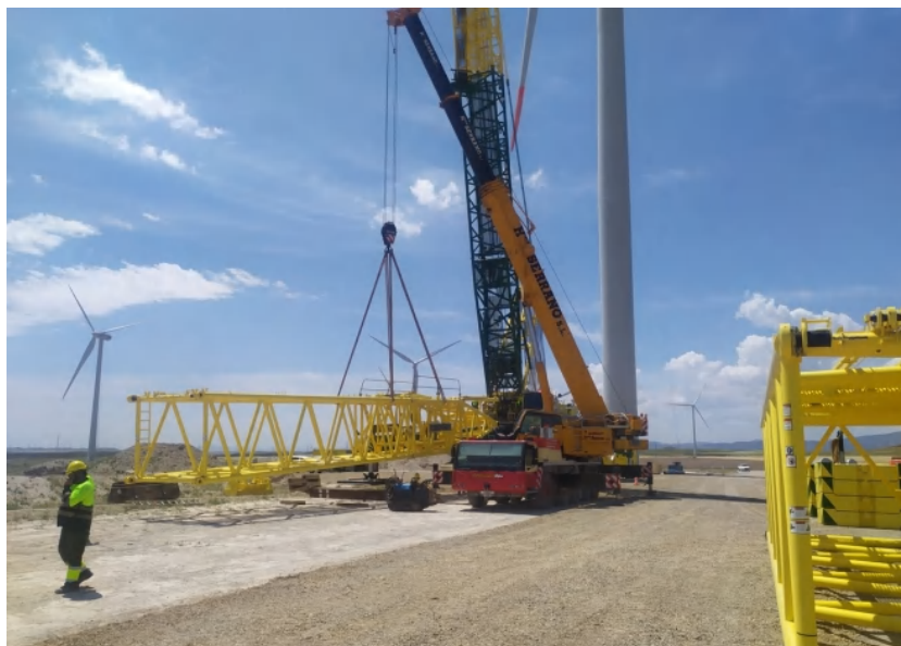
Foto 39. Proceso de desmontaje de las grúas durante la visita del 30/06/2022.
