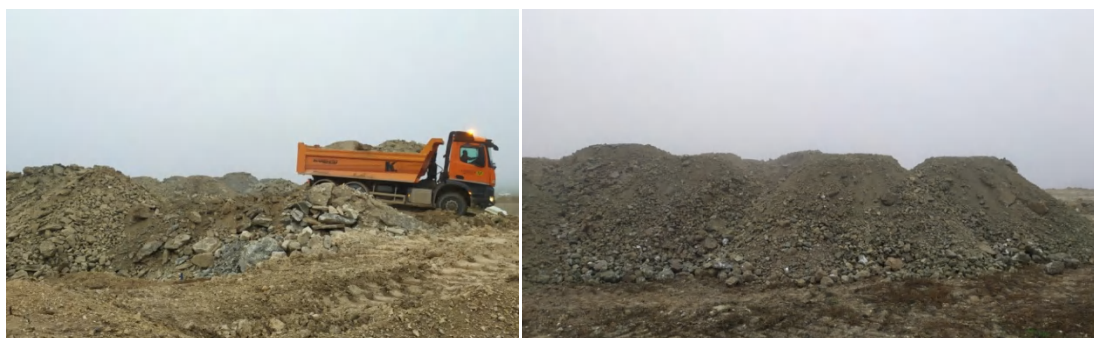
Foto 29. Ejemplos de acopios de tierra mineral sobre las plataformas.
