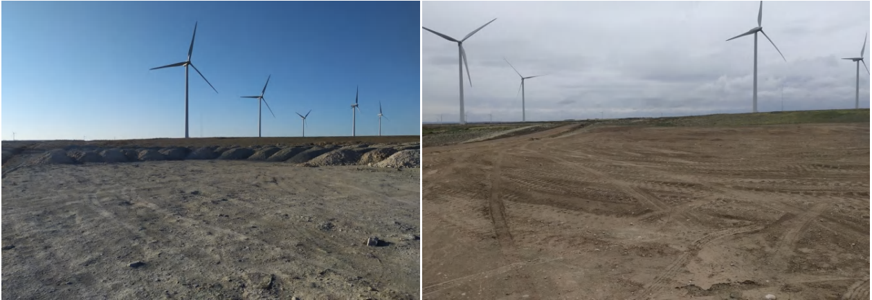
Foto 41. El campo de cultivo que se empleó de acopio de tierra mineral y vegetal (norte de la plataforma del aerogenerador 3) ha sido restaurado correctamente y recubierto con la tierra vegetal original. A la izquierda se muestra una foto antes de la restauración y a la derecha tras la restauración.
