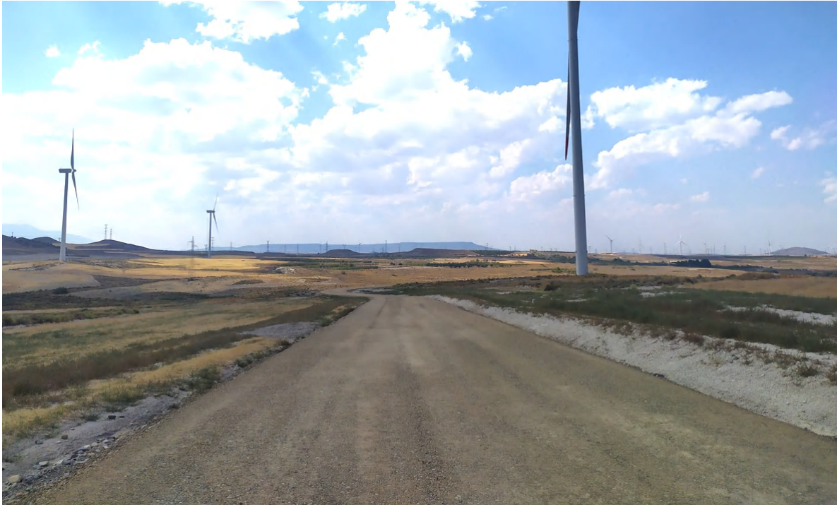
Foto 46. Vial de acceso de aerogenerador 2. A su derecha el cableado subterráneo enterrado y restaurado.
