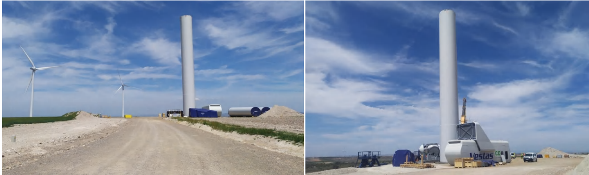
Foto 37. Primeras secciones de las torres de aerogeneradores 2 y 3 ya izadas el 16/05/2022.
