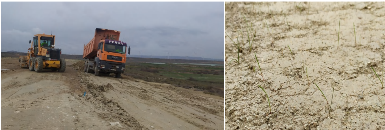
Foto 42. Camión volcando tierra vegetal sobre el talud norte de la plataforma del aerogenerador (izquierda) y primeros brotes de vegetación creciendo en la misma zona restaurada en posteriores visitas (correspondiente a una zona de cultivo).
