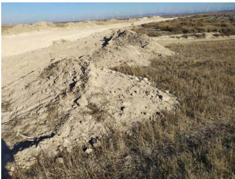
Foto 6. Acopio de tierra vegetal localizado sobre terreno de cultivo, evitando así acopiarse en las secciones de terreno natural como se observa en la sección superior derecha de la fotografía.
