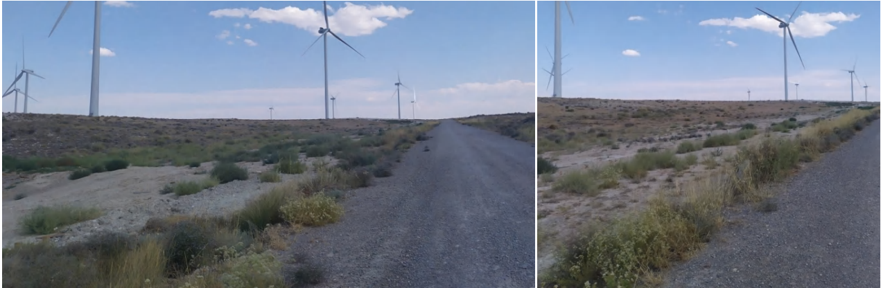
Foto 43. Superficie de los cables de evacuación enterrados entre SET Santo Cristo y el cruce de viales de aerogeneradores 3 y 2, restaurada y presentando una revegetación espontánea.
