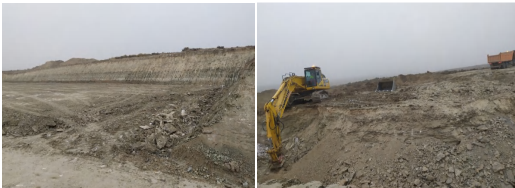
Foto 26. Excavación para nivelar la plataforma del aerogenerador 2 (16/12/2022)
