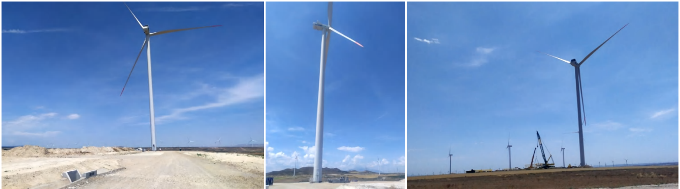
Foto 38. Todos aerogeneradores de la obra completamente ensamblados el 30/06/2022. (De izquierda a derecha, aerogenerador 1, 2 y 3).
