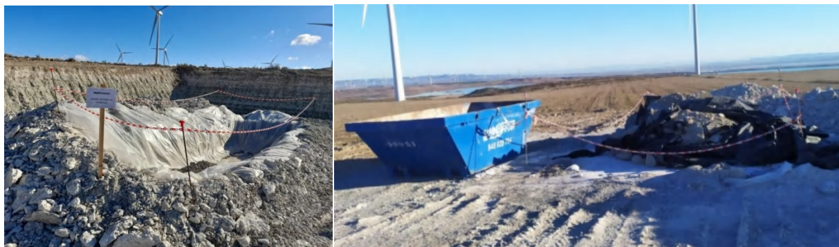
Foto 16. Piscinas de limpieza de hormigón. A la izquierda la piscina situada en la plataforma 2 antes de ser empleada, con su cartel de señalización, y a la derecha la piscina de la plataforma 3 con los residuos de hormigón almacenados preparada para ser finalmente retirada en un contenedor metálico.
