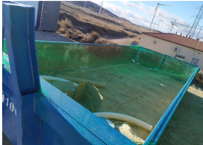
Foto 14. Malla de sujeción colocada sobre el contenedor de residuos sólidos urbanos
