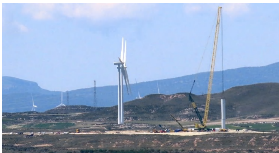
Foto 35. Izado de las secciones de la torre del aerogenerador 1 (Visita del 09/05/2022).
