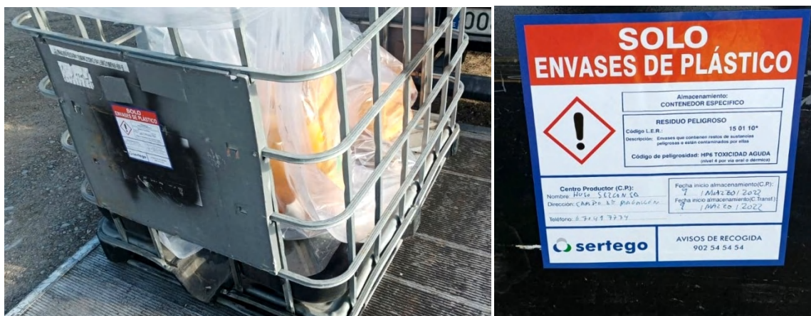
Foto 13. Recogida de los envases vacíos de productos de curado de hormigón (11/3/2022)
