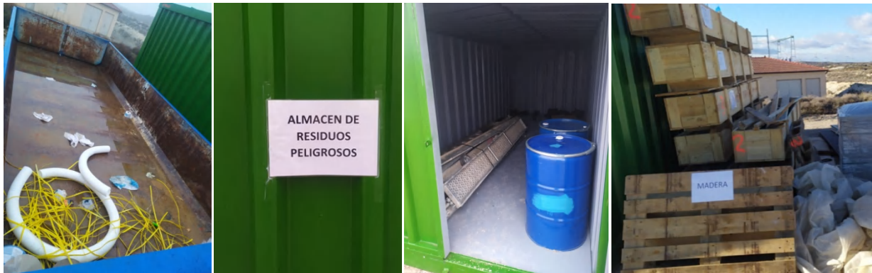
Foto 10. Punto limpio de residuos, mostrando de izquierda a derecha el contenedor de residuos sólidos urbanos, el cartel del almacén de residuos peligrosos, el interior de dicho almacén y el acopio de residuos de madera.
