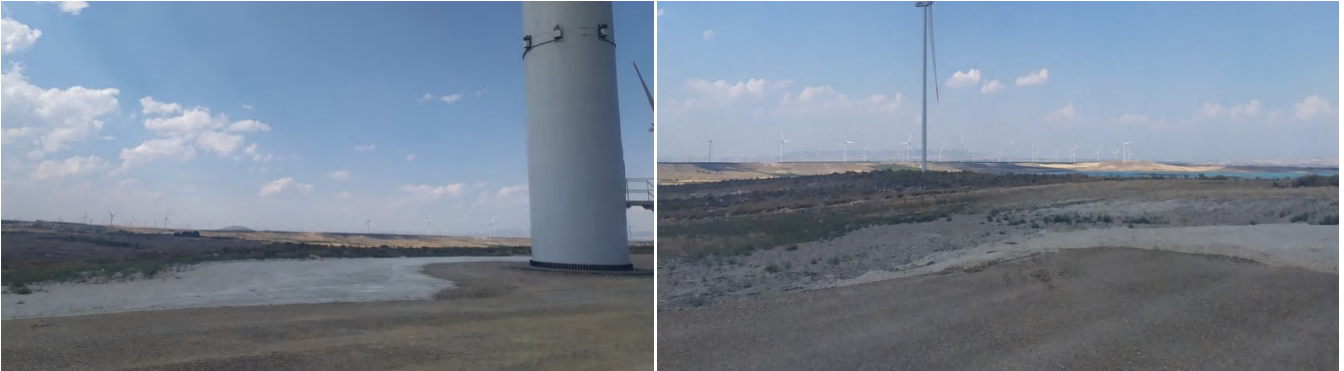
Figura 1. Plataforma del aerogenerador 2 acabada y restaurada con tierra vegetal las áreas de apoyo de maquinaria y grúas durante obra.
