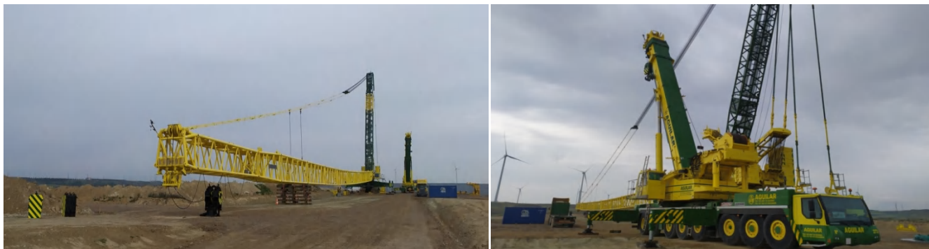
Foto 34. Montaje de las grúas para el izado de piezas de aerogenerador en la plataforma del aerogenerador 3 (Visita del 03/05/2022).
