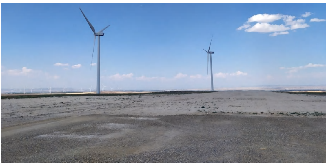
Foto 45. Plataforma del aerogenerador 3 acabada y restaurada con tierra vegetal las áreas de apoyo de maquinaria y grúas durante obra.
