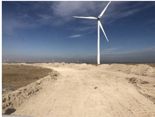
Foto 22. Comienzo de los desbroces y retirada de tierra vegetal (4/11/2021).
