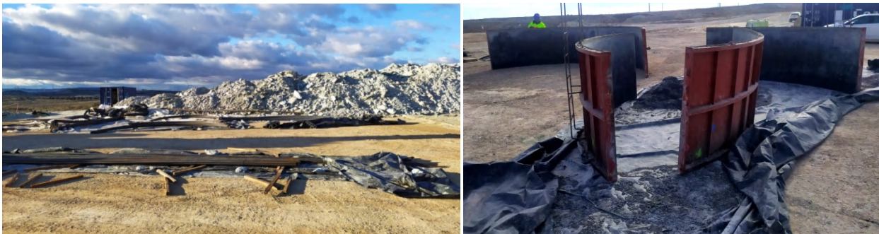
Foto 15. Lonas de plástico colocadas bajo diferentes piezas empleadas en el ferrallado y el hormigonado de la obra, con el fin de evitar la contaminación del suelo.
