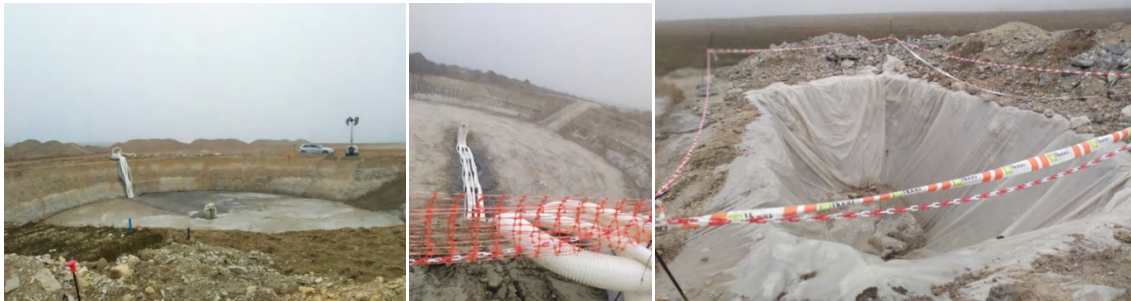
Foto 30. Fosos de aerogeneradores 3 y 2 con la capa de hormigonado de limpieza ya aplicada, y piscina de lavado de hormigón preparada (todas fotografías del 16/12/2021).
