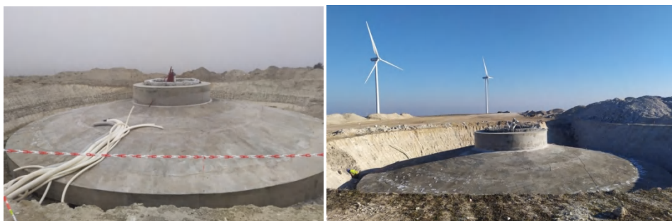
Foto 32. Cimentaciones del aerogenerador 2 (izquierda) y 3 (derecha) ya completadas el día 9/2/2022.
