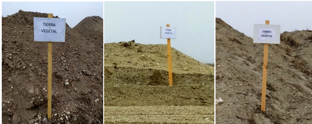
Foto 24. Carteles colocados para señalar los acopios de tierra vegetal a lo largo de la obra
