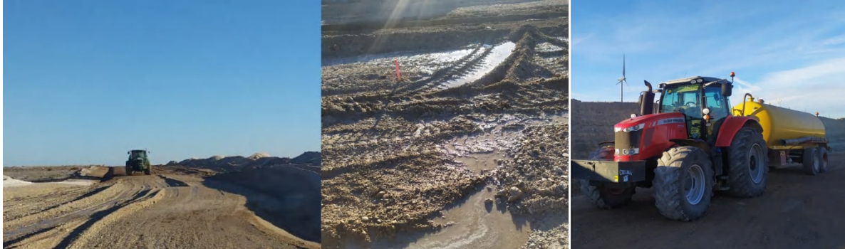
Foto 5. Riego de la superficie del vial de acceso a la obra de los futuros aerogeneradores 1 y 2 durante el 18/11/2021, y tractor con cisterna de riego aparcado en plataforma de aerogenerador 2.
