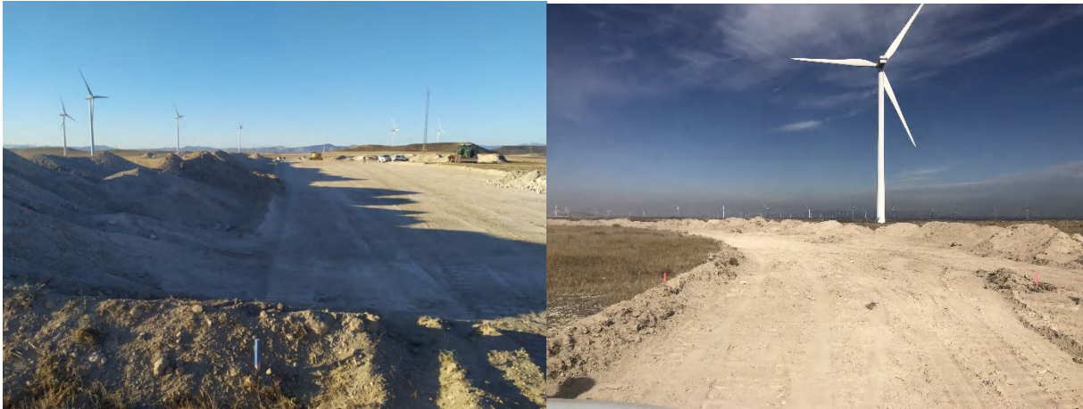
Foto 23. Ejemplos de acopios de tierra vegetal en plataforma del aerogenerador 3 y a lo largo del vial de acceso al aerogenerador 1 y 2.
