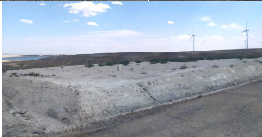
Foto 50. Plataforma del aerogenerador 1 acabada y restaurada con tierra vegetal las áreas de apoyo de maquinaria y grúas durante obra.
