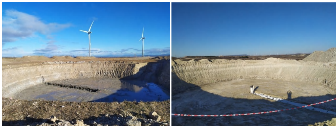
Foto 28. Distintas fases de excavación de los fosos de cimentación de los aerogeneradores.
