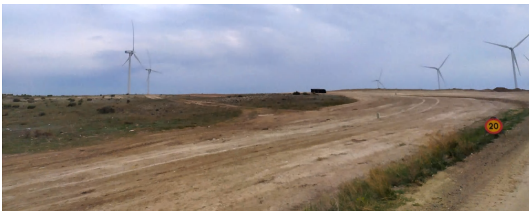
Foto 40. Vial de acceso en el cruce de aerogeneradores 2 y 3 ya restaurado.
