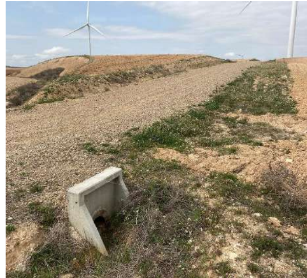
AG-05: Drenaje del vial
