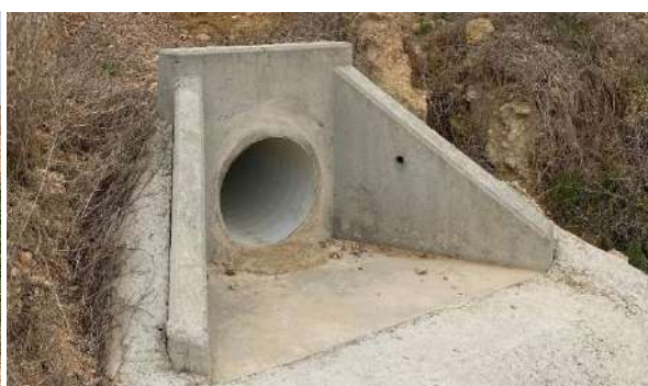
Foto nº21.: Drenaje del vial de acceso al PE
