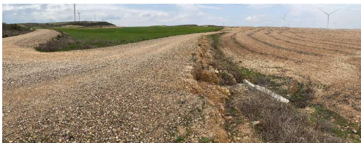
Foto nº21.: Drenaje del vial de acceso al PE
