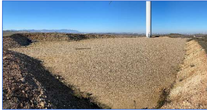
Taludes en desmonte (AG-01).
