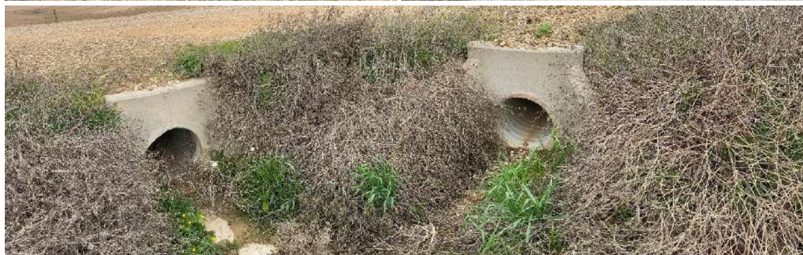
Foto nº22.: Detalle: Drenaje del vial de acceso al PE
