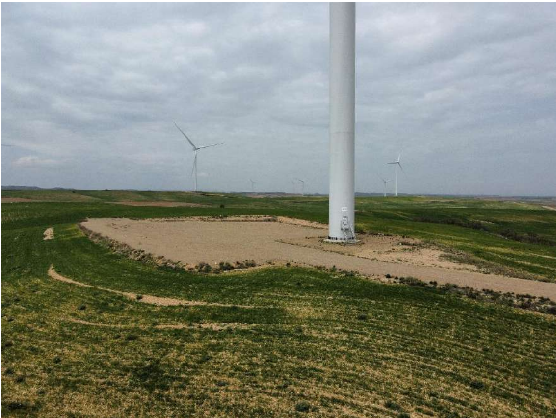
Foto nº8.: Plataforma del Aerogenerador AG-08
