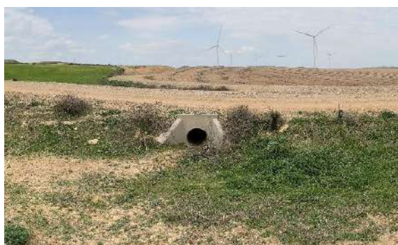
Foto nº21.: Drenaje del vial de acceso al PE
