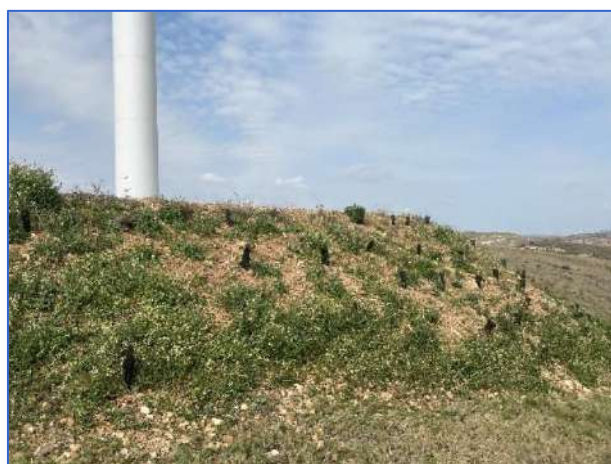
Estado general de los taludes restaurados. (AG-01)
