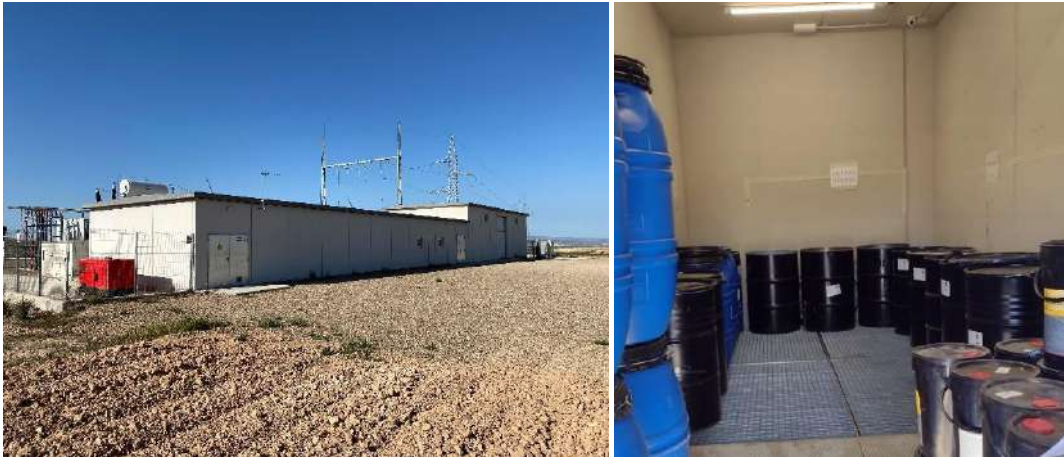
FOTOGRAFÍA DEL PUNTO LIMPIO
