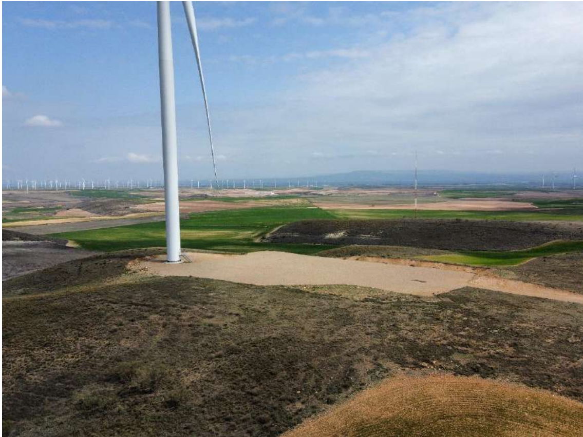
Foto nº1.: Plataforma del Aerogenerador AG-01
