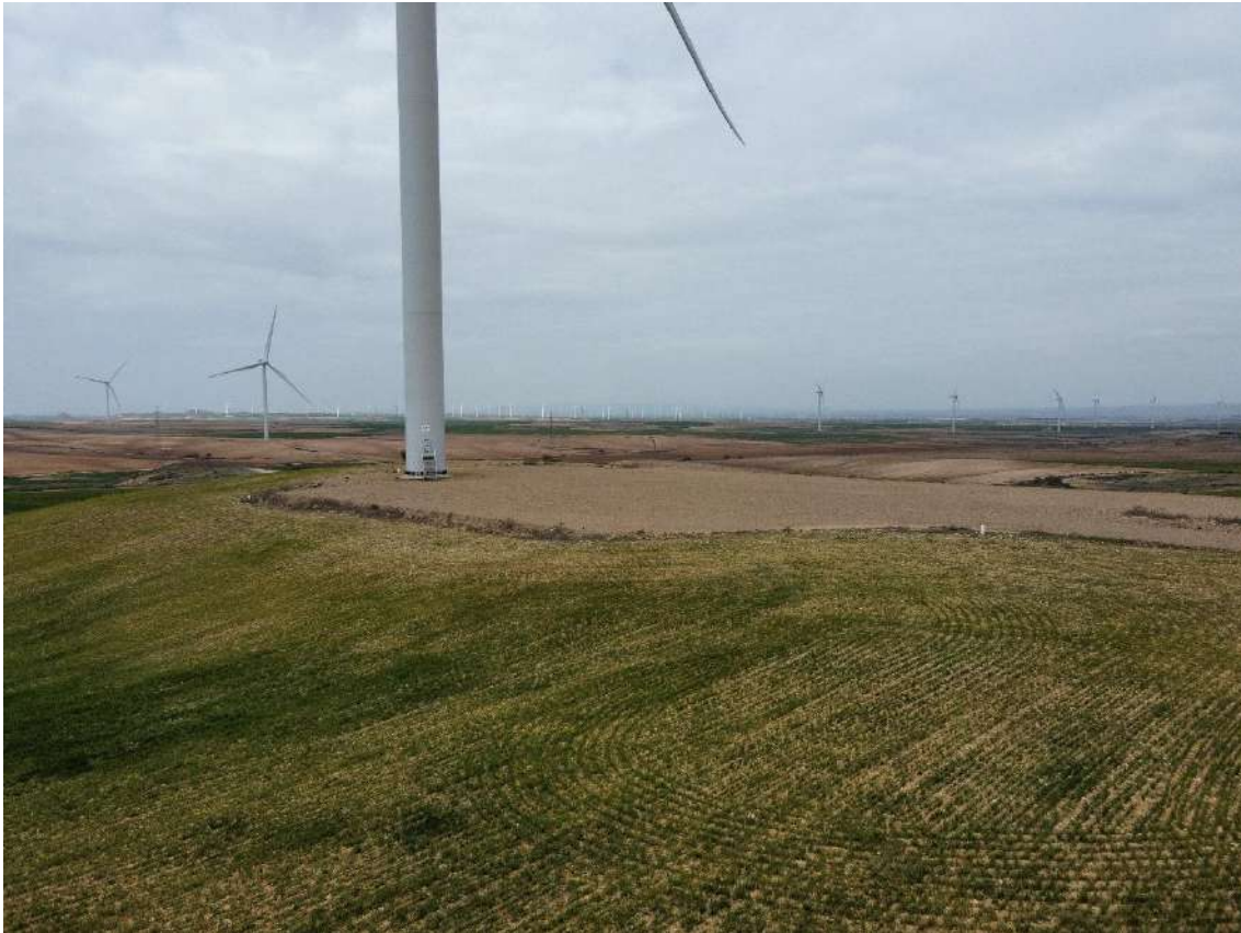
Foto nº7.: Plataforma del Aerogenerador AG-07
