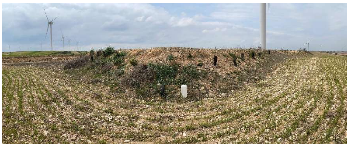
Foto nº16.: Detalle: Restauración AG-07
