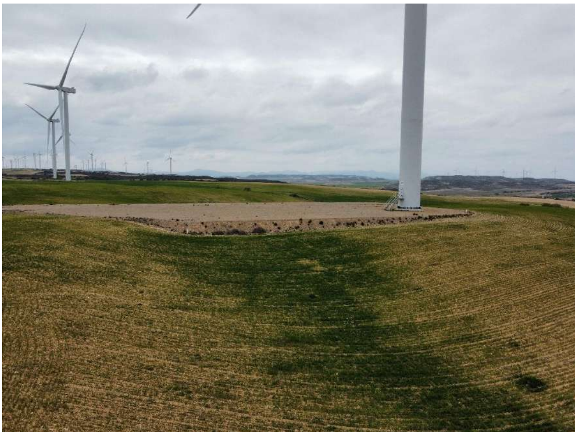
Foto nº6.: Plataforma del Aerogenerador AG-06
