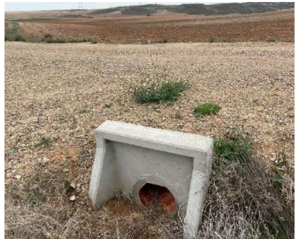
AG-04: Drenaje del vial
