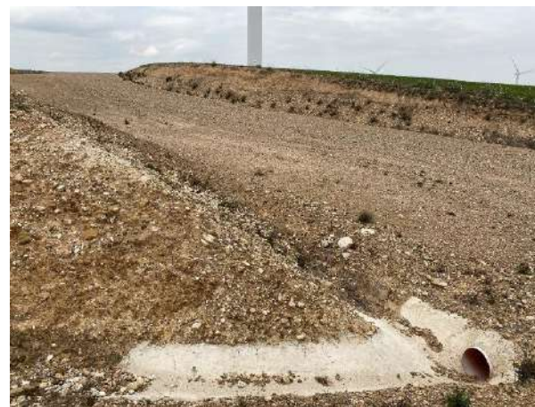
AG-06: Drenaje del vial
