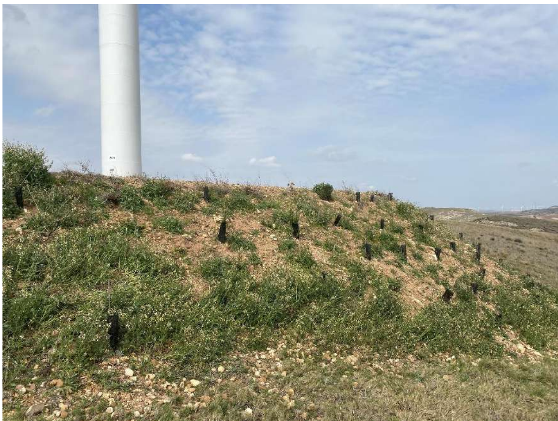
Foto nº12.: Detalle: Restauración AG-01 sobre terraplén
