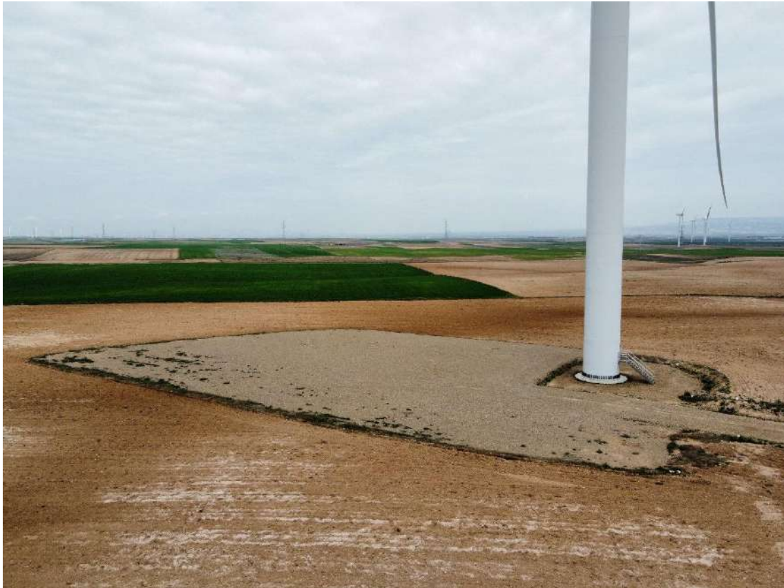
Foto nº5.: Plataforma del Aerogenerador AG-05
