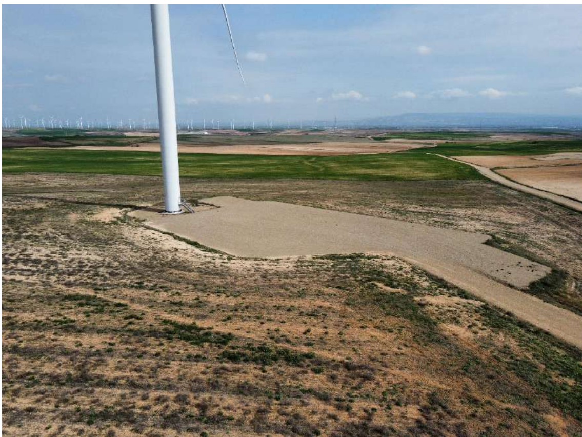
Foto nº2.: Plataforma del Aerogenerador AG-02
