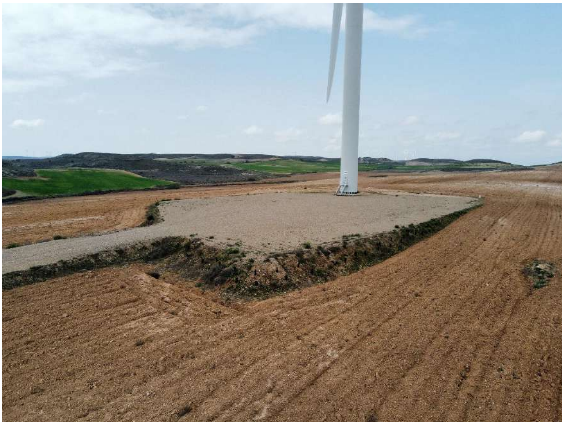
Foto nº4.: Plataforma del Aerogenerador AG-04
