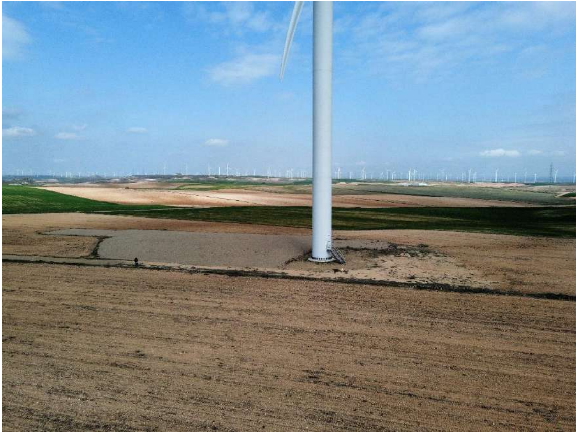
Foto nº3.: Plataforma del Aerogenerador AG-03
