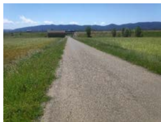
Figura 31: Camino asfaltado en el trazado de la línea de evacuación
