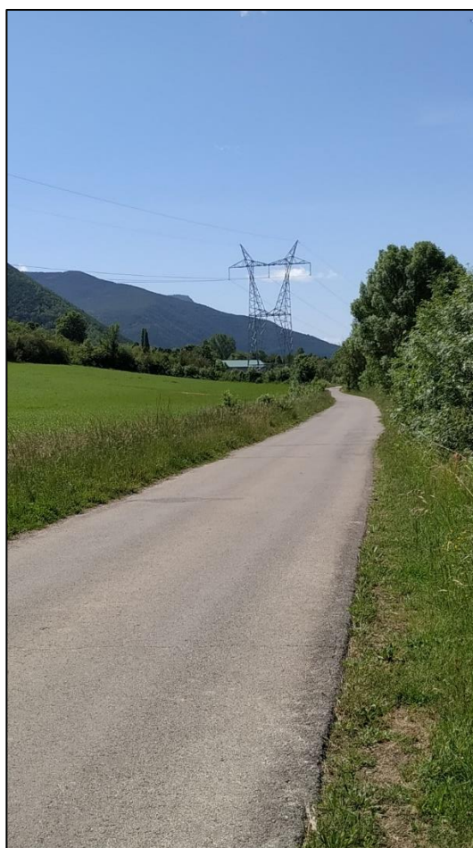
Apoyo de la línea de 220 kV que transcurre a lo largo del valle del río Gállego
