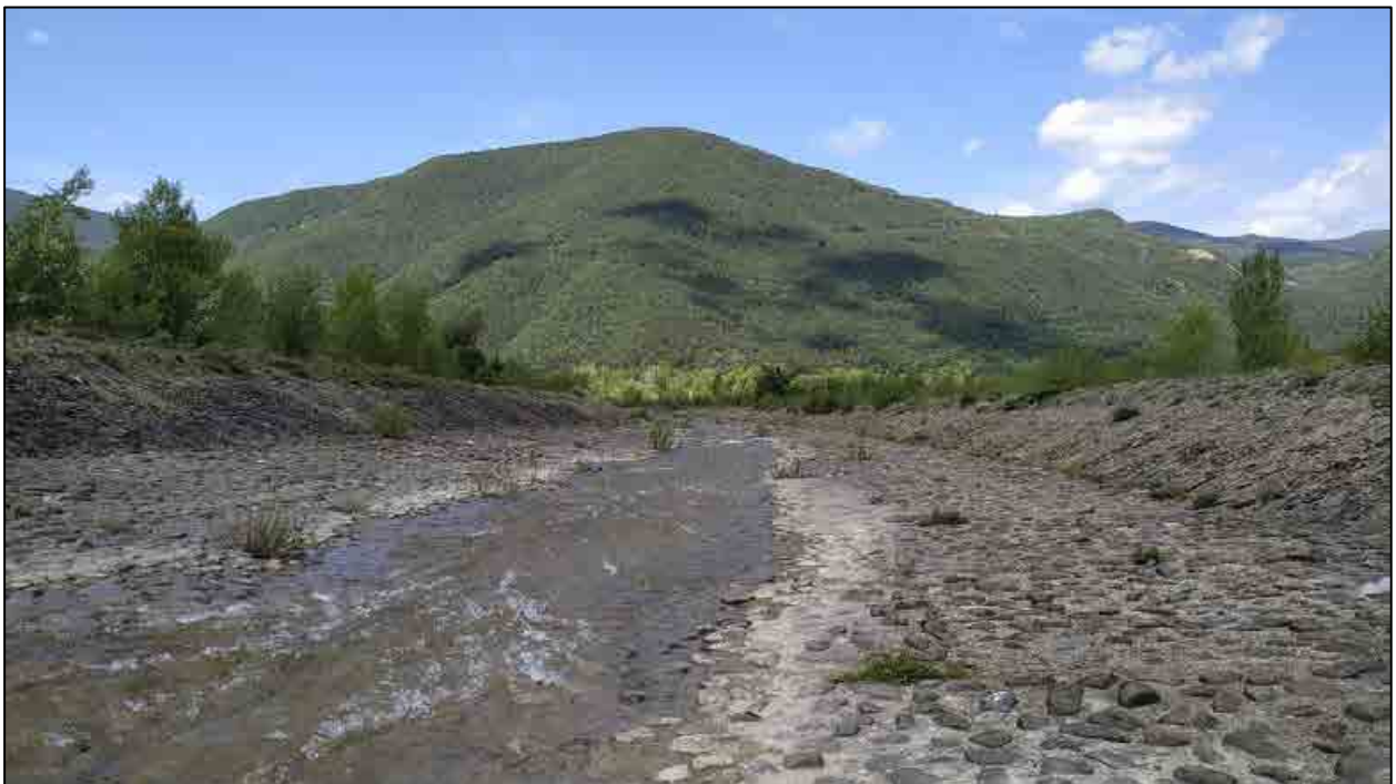
Vista de la canalización del barranco de Sía
