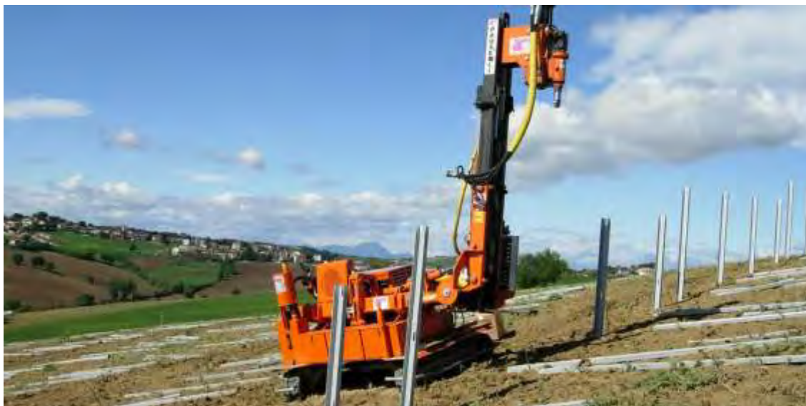
Ilustración 8: Máquina hinca postes. Fuente: Pauselli Group
