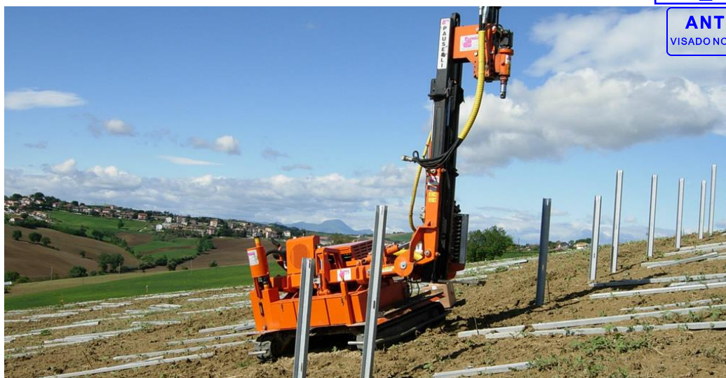
Ilustración 6: Máquina hincando postes. Fuente: Pauselli Group
