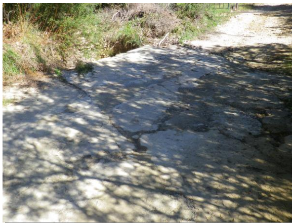
Foto 42. Construcción de badén.
