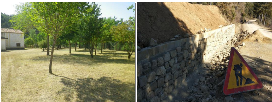
Fotos 1 y 2. Desbroces y preparación del muro en la casa forestal de Sibirana.
