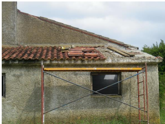
Fotos 12 a 16. Arreglos en fuentes/abrevaderos, vallado y corrales.
