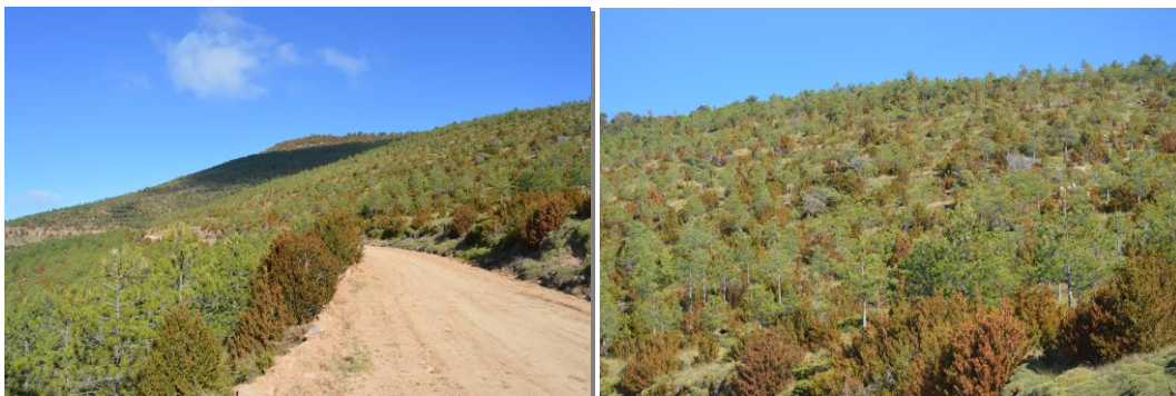
Fotos 17 y 18. Localización de los trabajos de prevención de incendios realizados en 2017.
