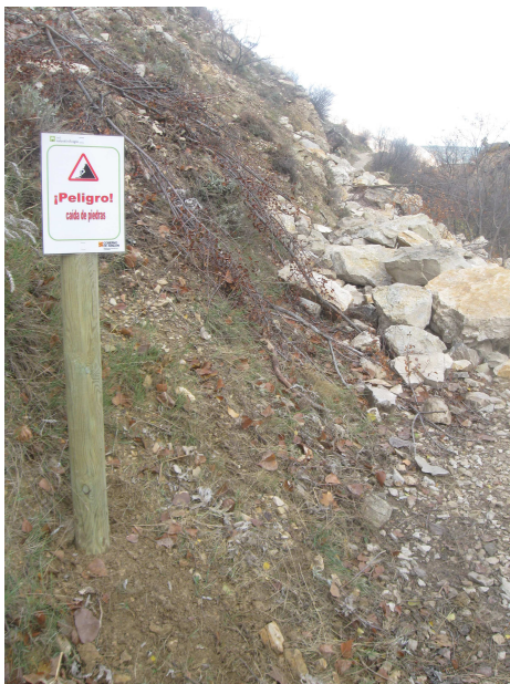
Colocación de señal de peligro caída de piedras en Pitarque
