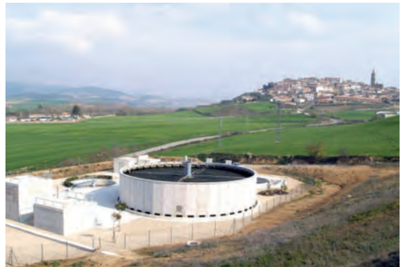
Figura 7.26. Planta depuradora de Lechos Bacterianos
