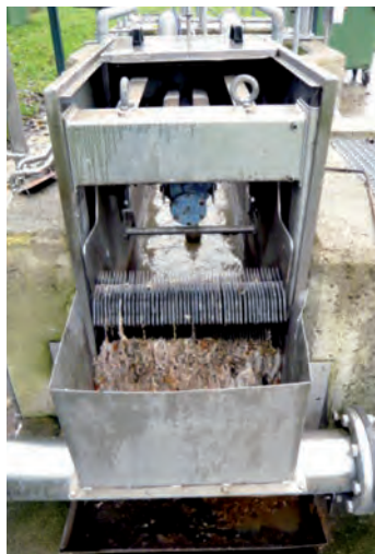
Figura 7.31. Pretratamiento de Lecho Bacteriano mediante tamiz deslizante
