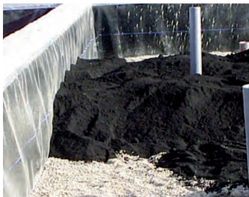
Figura 6.49. Colocación de la capa de turba
