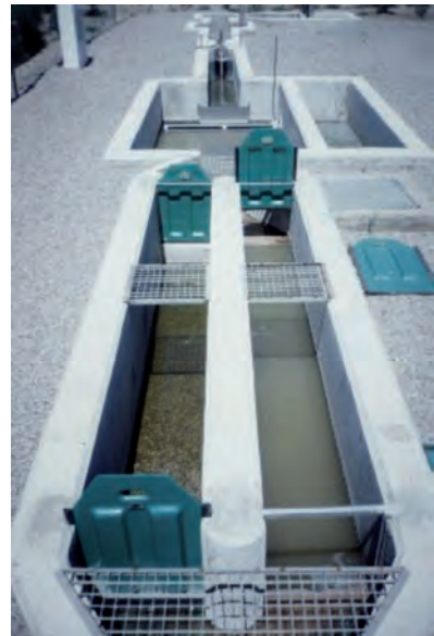
Figura 4.8. Desarenador estático de doble canal
