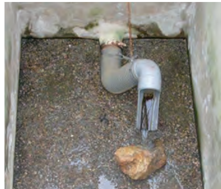
Figura 6.20. Evacuación de las aguas tratadas en un Humedal Artificial de Flujo Horizontal (PECC-Sevilla)
