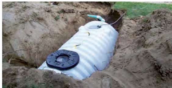
Figura 5.10. Instalación de una Fosa Séptica prefabricada en material plástico
