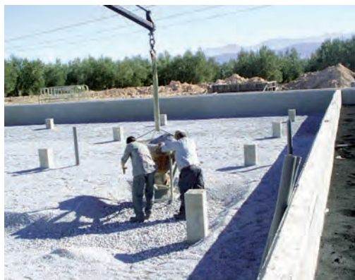
Figura 6.48. Colocación de la capa de áridos sobre la que descansa la turba
