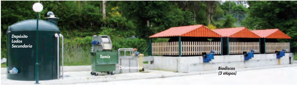
Figura 7.47. Pretratamiento mediante tamiz rotativo previo a un sistema CBR
