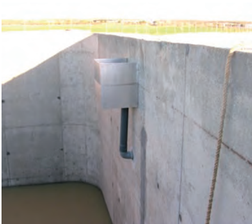
Figura 6.60. Detalle de la zona de salida de una Laguna Anaerobia
