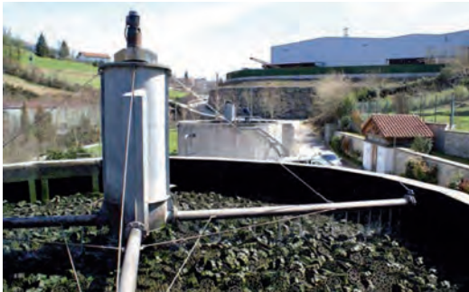
Figura 7.37. Sistema de distribución motorizado, con motovariador
