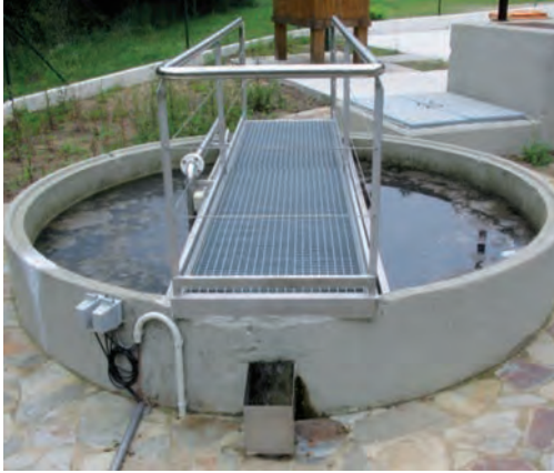
Figura 7.55. Decantador secundario estático de flujo vertical
