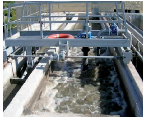
Figura 4.11. Desarenador-desengrasador aireado con puente móvil
