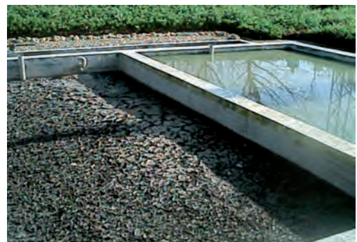
Figura 6.41. Filtros de Turba en operación y fase de secado
