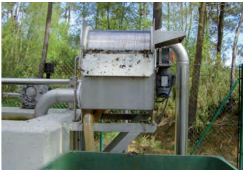
Figura 7.47. Pretratamiento mediante tamiz rotativo previo a un sistema CBR
