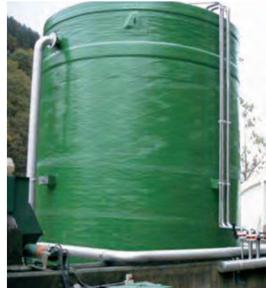
Figura 7.66. Reactor MBBR circular prefabricado
