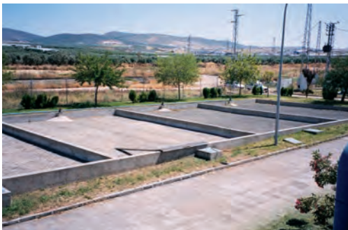
Figura 9.4. Eras de Secado para la deshidratación de los fangos
