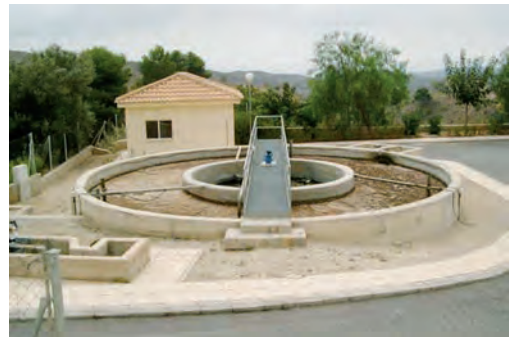
Figura 7.3. Reactor biológico circular, con el decantador en su interior. EDAR Aigües (Alicante)
