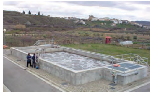
Figura 7.2. Reactor biológico rectangular. EDAR Alcanadre (La Rioja)
