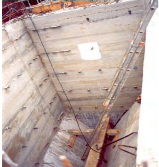
Figura 5.19. Tanque Imhoff con la zona de decantación en PRFV
