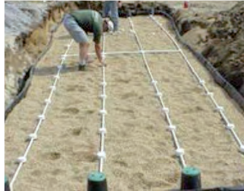
Figura 6.23. Filtro Intermitente de Arena
