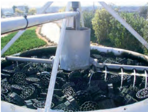
Figura 7.36. Sistema de distribución (izquierda) y detalle de soporte plástico (derecha)
