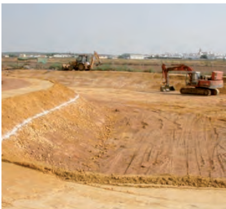
Figura 6.57. Construcción del confinamiento
