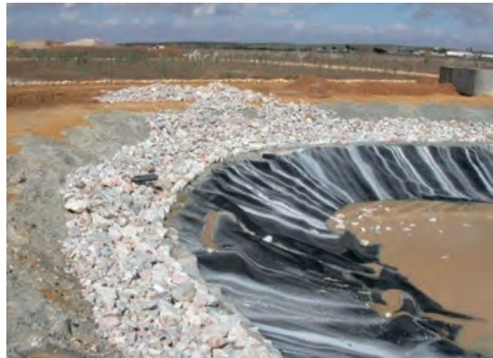
Figura 6.59. Encachado de los taludes de la laguna
