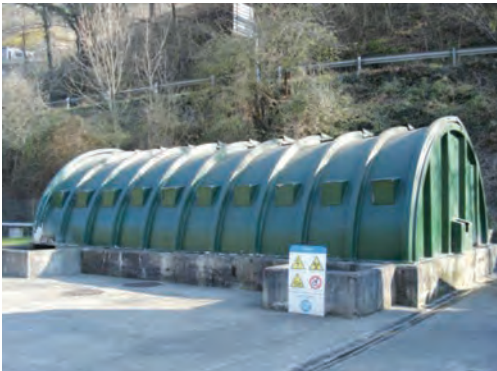
Figura 7.40. Sistema de biodiscos en Santesteban (Navarra)
