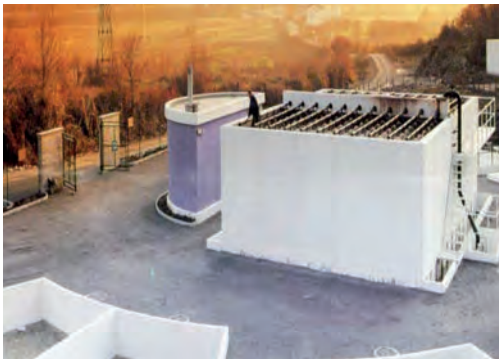
Figura 7.22. Lecho Bacteriano con sistema de distribución fijo
