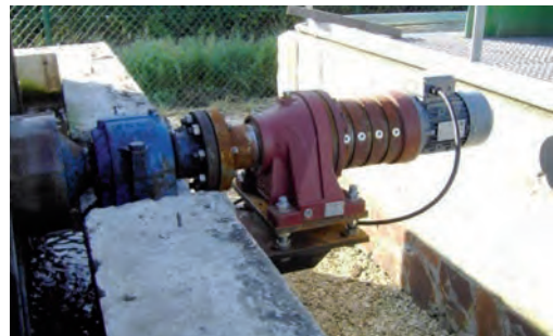
Figura 7.53. Motor de giro de un CBR
