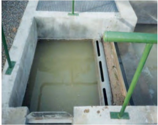
Figura 4.10. Desengrasador estático con recogedor de grasas superficial
