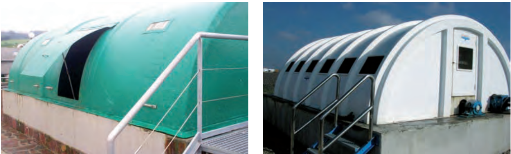
Figura 7.54. Distintos tipos de cubiertas de CBR visitables
