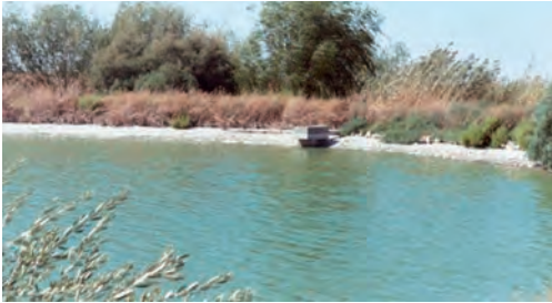
Figura 6.53. Lagunaje. EDAR de Lantejuela (Sevilla)
