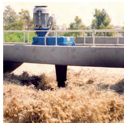
Figura 7.15. Aireación mediante turbina superficial
