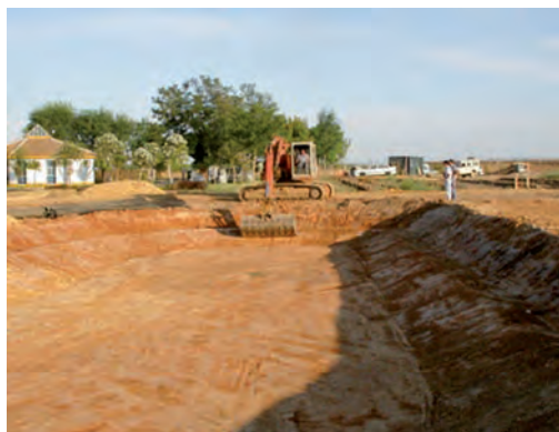
Figura 6.16. Colocación sustrato filtrante
