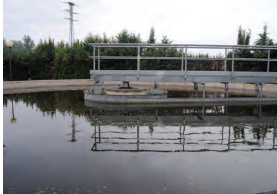
Figura 7.38. Decantador secundario de una EDAR de Lechos Bacterianos
