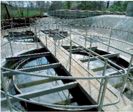
Figura 5.25. Decantadores primarios
