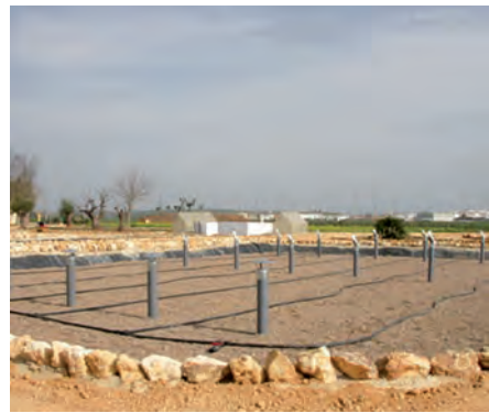
Figura 6.20. Evacuación de las aguas tratadas en un Humedal Artificial de Flujo Horizontal (PECC-Sevilla)
