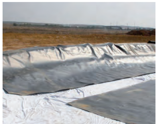
Figura 6.58. Impermeabilización del confinamiento
