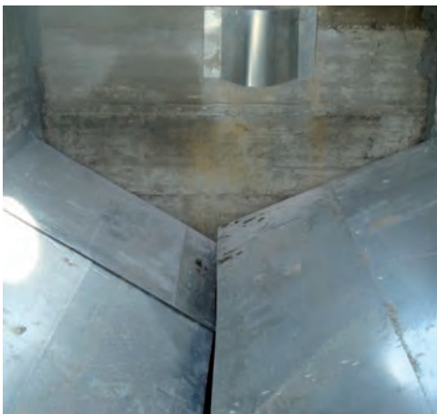
Figura 5.18. Tanque Imhoff con la separación entre las zonas de decantación y digestión en chapa metálica
