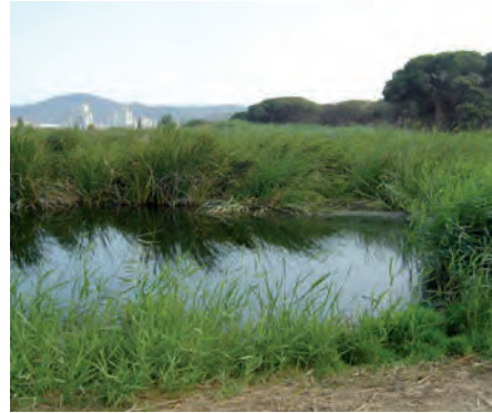
Figura 6.4. Humedal Artificial de Flujo Horizontal. EDAR de Verdú, 2.000 h-e (Lérida)
