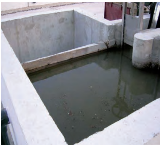
Figura 4.1. Obra de llegada y aliviadero
