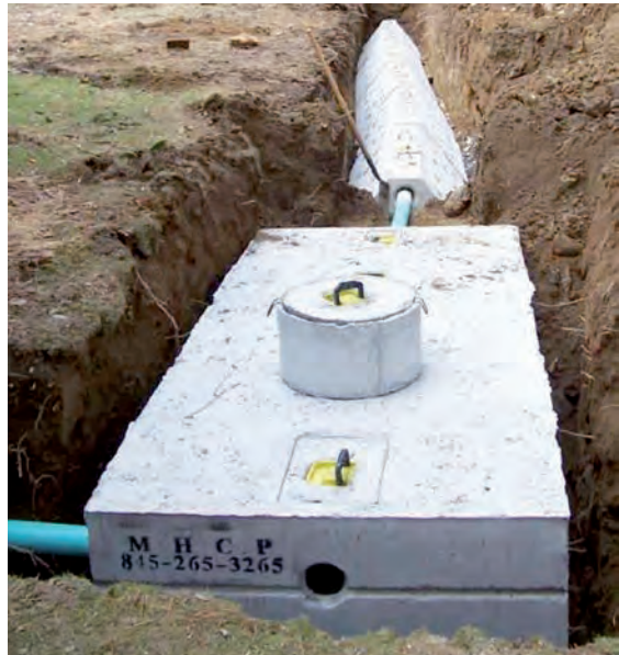
Figura 5.10. Instalación de una Fosa Séptica prefabricada en material plástico
