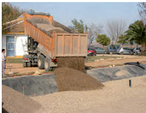
Figura 6.16. Colocación sustrato filtrante
