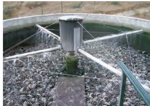
Figura 7.23. Lecho Bacteriano con sistema de distribución móvil
