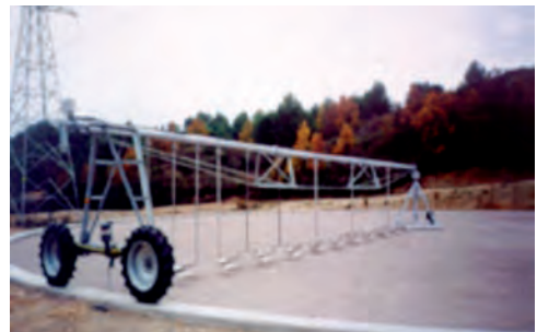
Figura 6.35. Unidad de Infiltración-Percolación en la EDAR de Els Hostalets de Pierola (Barcelona)
