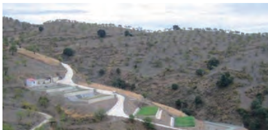
Figura 6.11. Combinación de Humedales de Flujo Vertical. EDAR de Albodón (Granada). 800 h-e
