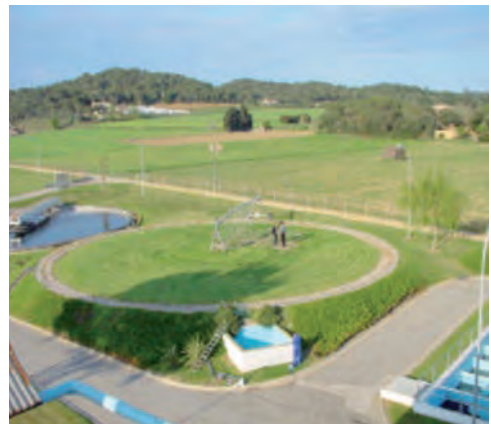
Figura 6.32. Instalación de afino mediante Infiltración-Percolación en la EDAR de Palamós/Vall-Ilòbrega (Girona)
