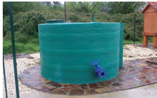
Figura 7.57. Depósito de fangos prefabricado en material plástico. EDAR Limiñon (La Coruña)
