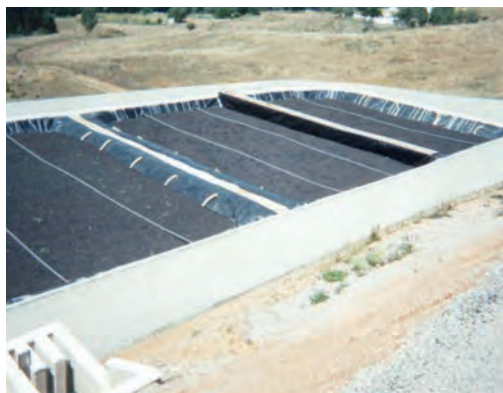
Figura 6.48. Colocación de la capa de áridos sobre la que descansa la turba
