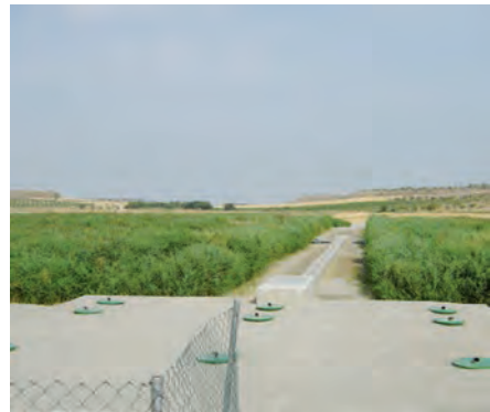
Figura 6.5. Humedal Artificial de Flujo Subsuperficial Vertical para 100 h-e (PECC-Sevilla)
