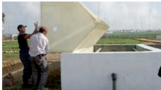
Figura 5.19. Tanque Imhoff con la zona de decantación en PRFV
