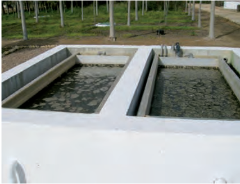
Figura 5.18. Tanque Imhoff con la separación entre las zonas de decantación y digestión en chapa metálica
