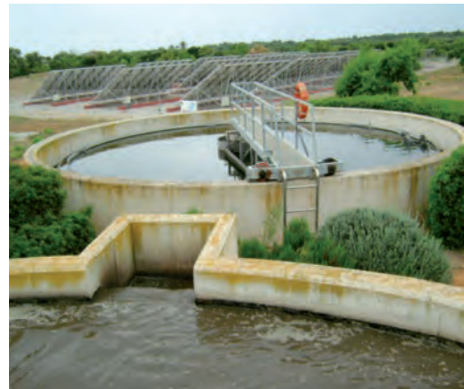
Figura 7.17. Decantador circular con raquetas. EDAR SA Rapita - Campos, (Islas Baleares)
