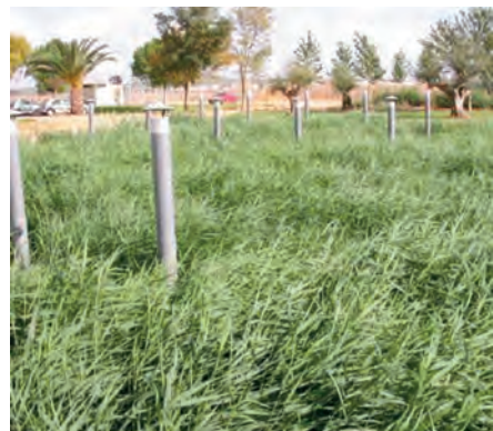
Figura 6.5. Humedal Artificial de Flujo Subsuperficial Vertical para 100 h-e (PECC-Sevilla)
