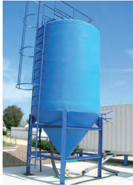
Figura 9.2. Espesador de fangos por gravedad
