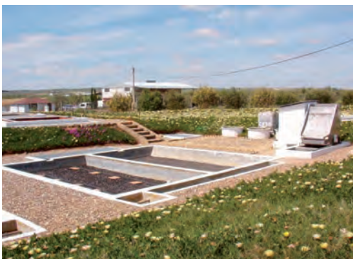
Figura 6.40. Filtros de Turba (PECC-Sevilla)
