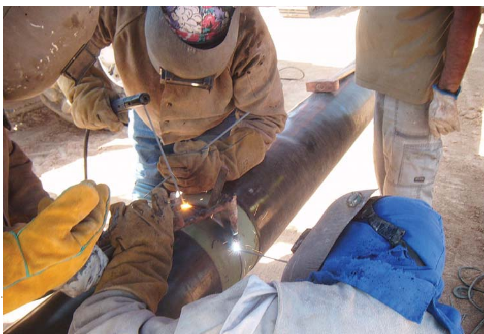
Fotografía 13.3-2. Construcción del gasoducto a Caspe
