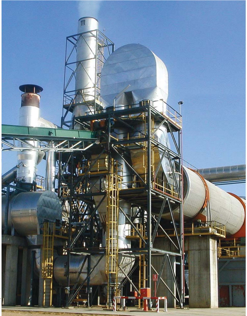
Fotografía 9.3-2. Central de cogeneración de 24,9MW (Cella, Teruel)
