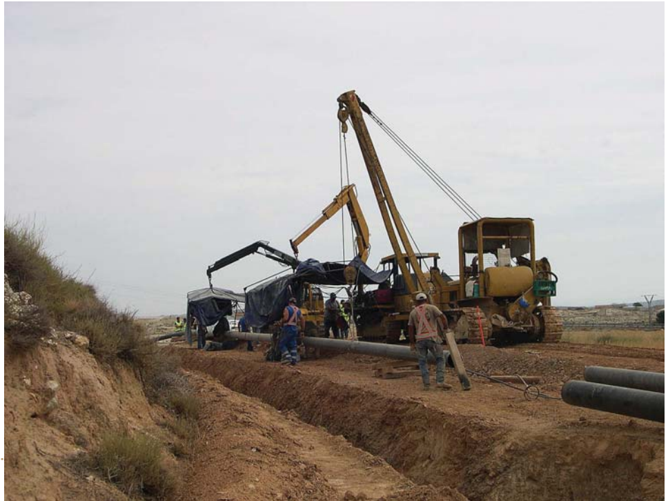
Fotografía 10.3-2. Construcción del gasoducto a Belchite
