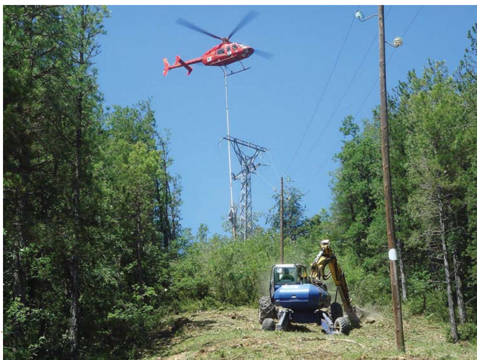
Fotografía 13.2-1. Mantenimiento de líneas eléctricas
