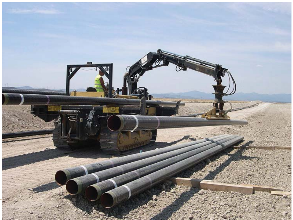
Fotografía 10.3-3. Construcción del gasoducto a Borja
