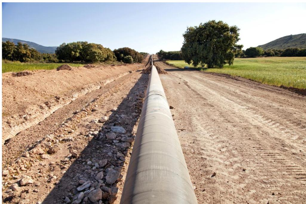
Tendido de la tubería de acero durante un gasoducto. Foto Redexis Gas
