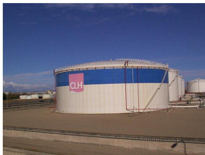
Depósitos Compañía Logística de Hidrocarburos (Zaragoza)
