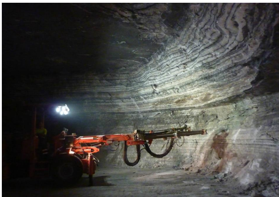
Figura 5. Explotación subterránea de sal gema en Remolinos (Zaragoza)
