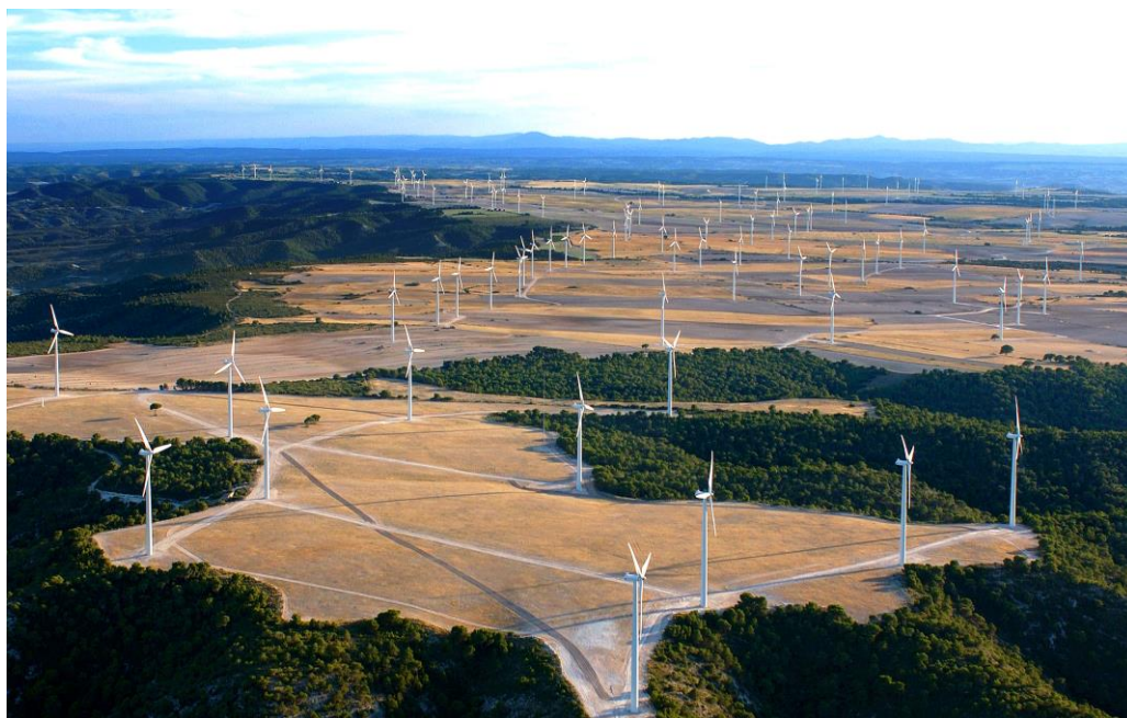
Energía Eólica en la Plana (Zaragoza)
