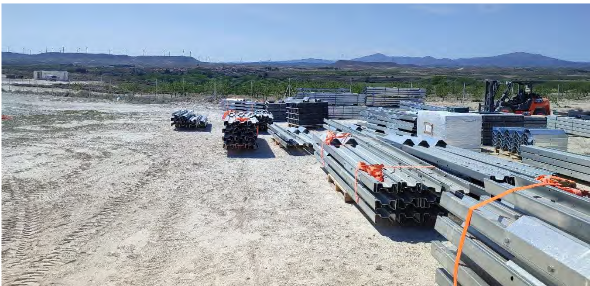
Fotografía 2. Zona de acopio de las hincas.
