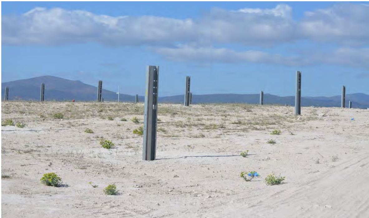
Fotografía 4. Primeras hincas colocadas.
