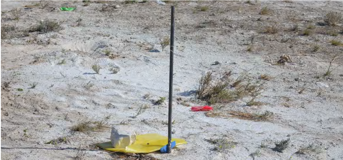
Fotografía 1. Señalización para la colocación de las hincas.
