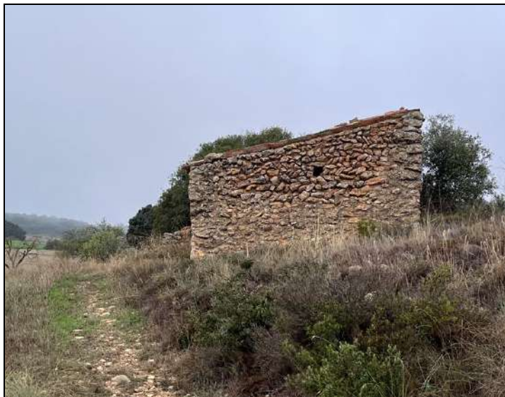
Imagen 4: Fotografía de la antigua edificación agrícola, en estado de semirruina, ubicada junto al camino de acceso interior de la parcela que conduce hasta la zona de cultivo que sí será objeto de explotación.
