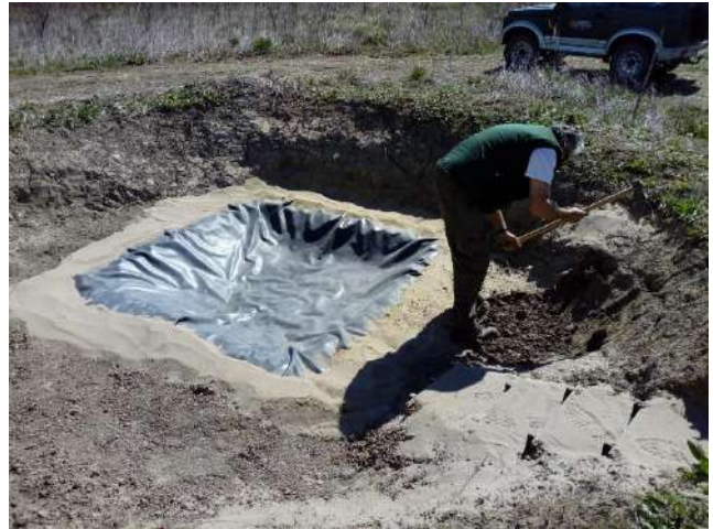
Fotos 12 y 13. Trabajos de instalación de balsa.
