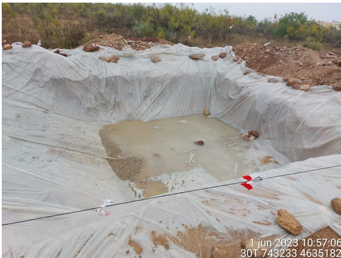
Imagen 3. Pozo de lavado en SC2-01 en buenas condiciones tras ser utilizado.
