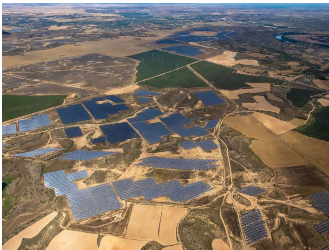
Planta fotovoltaica en Escatrón, Zaragoza
