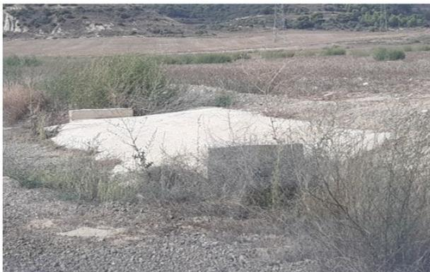
Fig. 1 Tubo de drenaje semitaponado con vegetación arbustiva en vial de acceso al PE ML5. Fuente: Elaboración propia
