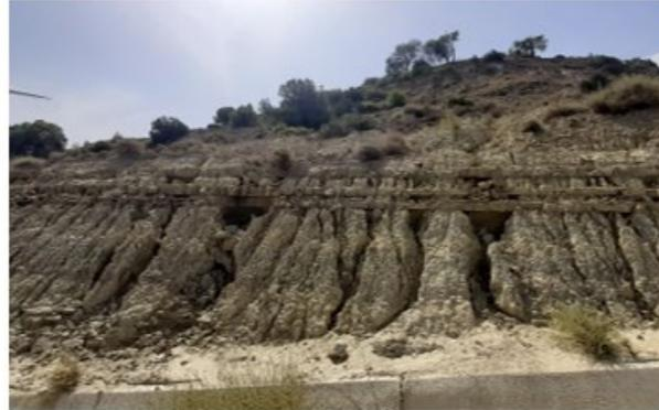
Fig. 3 Erosión hídrica en materiales margosos del talud de desmonte del vial de acceso al PE ML5. Fuente: Elaboración propia
