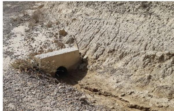
Fig. 2 Tubo de drenaje taponado por sedimentos en vial de acceso al aero ML5.09. Fuente: Elaboración propia
