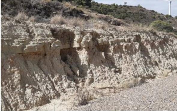
Fig. 2 Erosión hídrica en materiales margosos del talud de desmonte de plataforma del aereo ML5.05. Fuente: Elaboración propia
