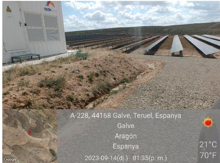
Ilustración 4. Acúmulo de sedimentos en canaletas del CT en zona1.
