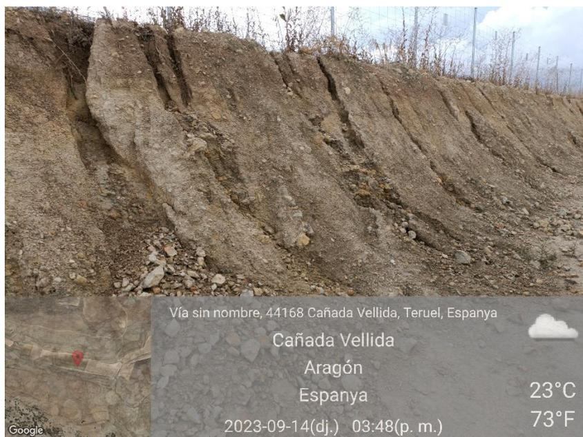
Ilustración 6. Taludes con erosión zona5
