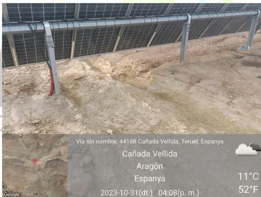
Ilustración 7. Erosión entre seguidores de la zona5
