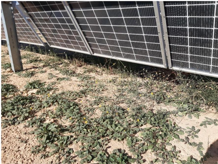
Fig. 1 Vegetación incidiendo en paneles fotovoltaicos.
