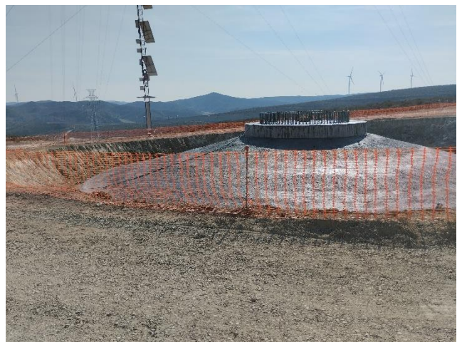
Izda., montaje de la jaula de pernos del ACS 03. Dcha., zapata hormigonada del ACS 04
