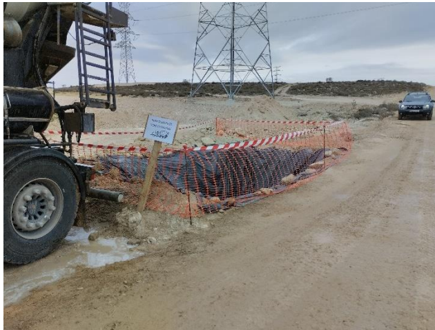
Dispositivos para la recogida del agua de limpieza de las canaletas de las cubas que participan en el hormigonado de las zapatas de los aerogeneradores: Izda., dispositivo junto al acceso al ACS 02. Dcha., dispositivo junto al acceso al ACS 03.
