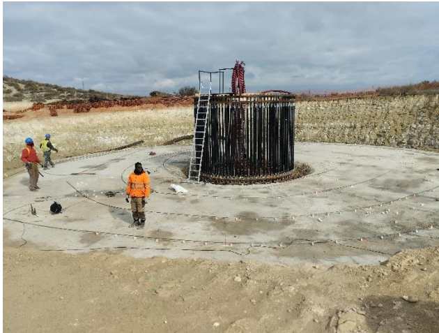
Izda., avances en el montaje de la jaula de pernos del ACS 03. Dcha., jaula de pernos del ACS 04, totalmente montada
