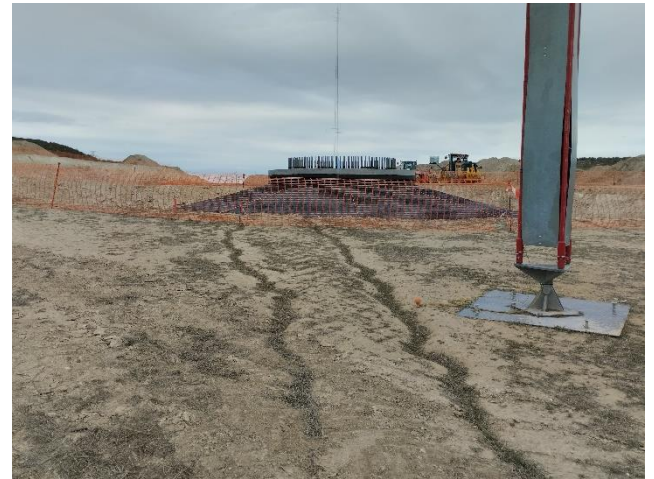
Izda., zapata hormigonada del ACS 03. Dcha., zapata hormigonada y con pintura asfáltica del ACS 04.
