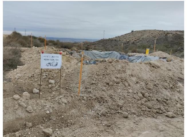
Dispositivos para la recogida del agua de limpieza de las canaletas de las cubas que participan en el hormigonado de las zapatas de los aerogeneradores: Izda., dispositivo junto al acceso al ACS 02. Dcha., dispositivo junto al acceso al ACS 03.
