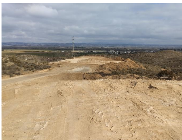
Plataforma del ACS 01: no será necesario reubicar la tierra vegetal copiada en el borde de la zona de obras -que continúa correctamente jalonada- que será reextendida en los taludes y en las plataformas auxiliares.
