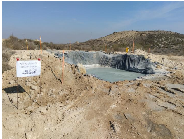
Izda., dispositivo para limpieza de cubas junto al vial de acceso al ACS 03
