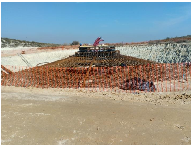
Izda., montaje de la jaula de pernos del ACS 03. Dcha., zapata hormigonada del ACS 04
