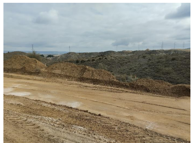
Plataforma del ACS 01: no será necesario reubicar la tierra vegetal copiada en el borde de la zona de obras -que continúa correctamente jalonada- que será reextendida en los taludes y en las plataformas auxiliares.
