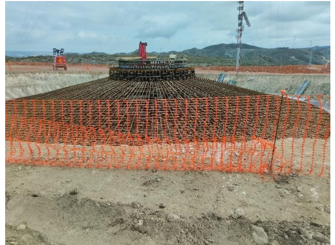
Izda., avances en el montaje de la jaula de pernos del ACS 03. Dcha., jaula de pernos del ACS 04, totalmente montada
