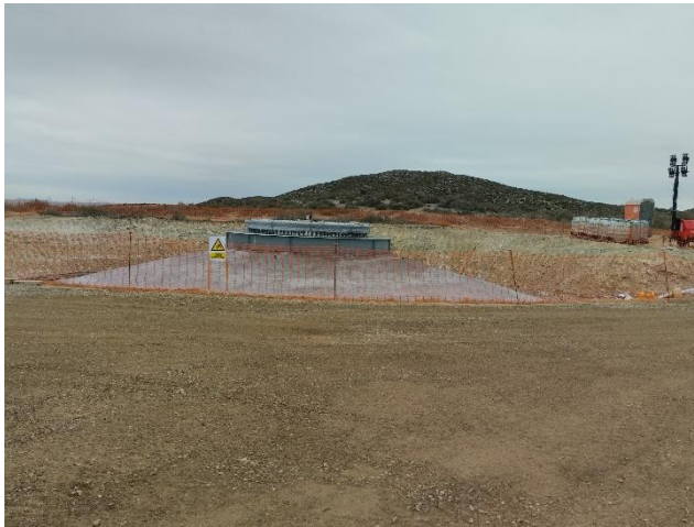
Izda., zapata hormigonada del ACS 03. Dcha., zapata hormigonada y con pintura asfáltica del ACS 04.
