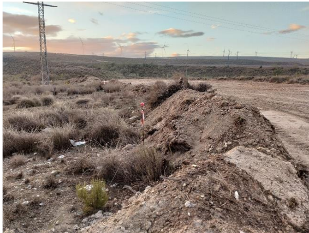
Jalonado correcto de delimitación de obras adyacentes a vegetación natural. Izda., vial de conexión de los sectores oeste y centro del PE. Dcha., vial de conexión TM – ACS 04 (16-12-22).
