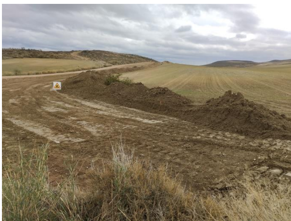
Inicio de desbroce en el vial de acceso y la plataforma del ACS 03. Afección solo a cultivos Tierra vegetal correctamente segregada (23-11-22)
