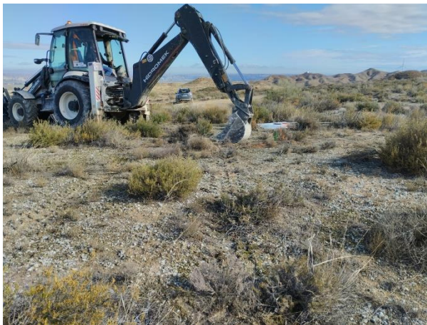
Colocación de anclajes de los tirantes de la torre de calibración. Afecciones mínimas y reversibles (23-11-22)
