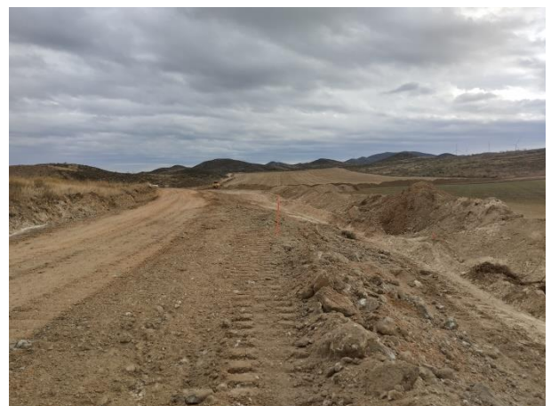
Inicio de desbroce en el vial de acceso y la plataforma del ACS 03. Afección solo a cultivos Tierra vegetal correctamente segregada (23-11-22)
