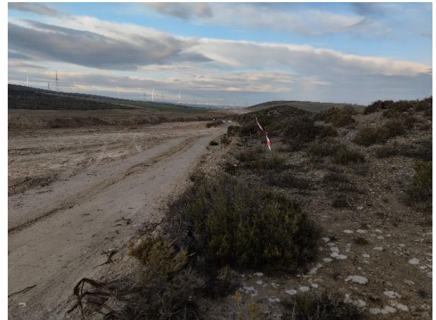
Jalonado correcto de delimitación de obras adyacentes a vegetación natural. Izda., vial de conexión de los sectores oeste y centro del PE. Dcha., vial de conexión TM – ACS 04 (16-12-22).
