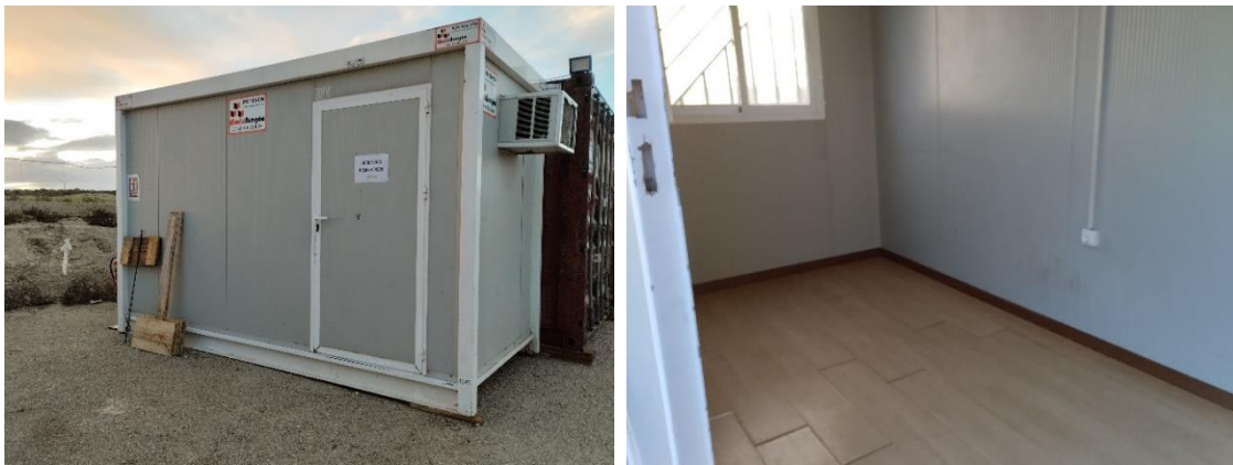
Punto limpio de RP, en fase de instalación (16-12-22)
