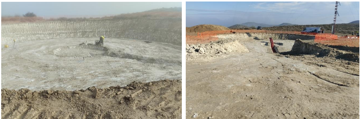
Excavación de las zapatas del ACS 03 (Izda.), y ACS 04, el 21-12-22.
