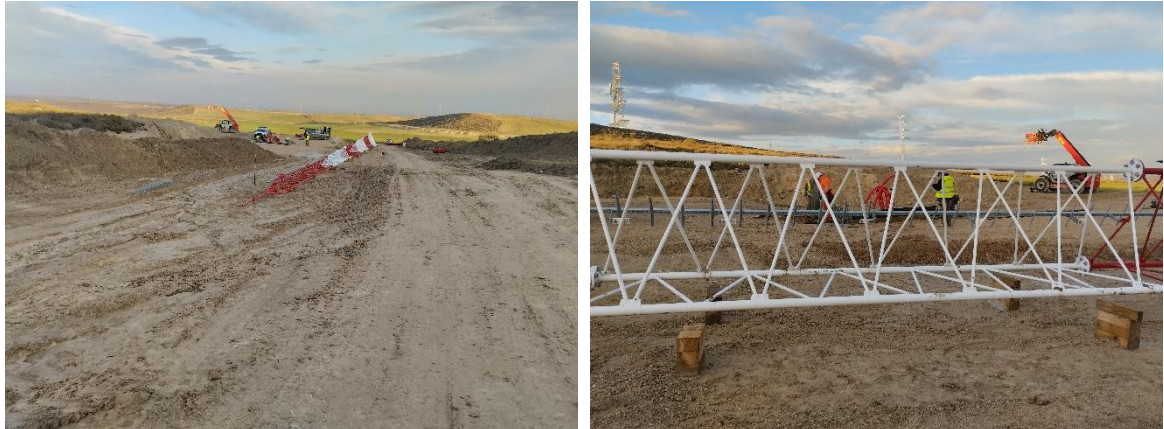
Completada la cimentación, se ultima el montaje de la TM (16-12-22).
