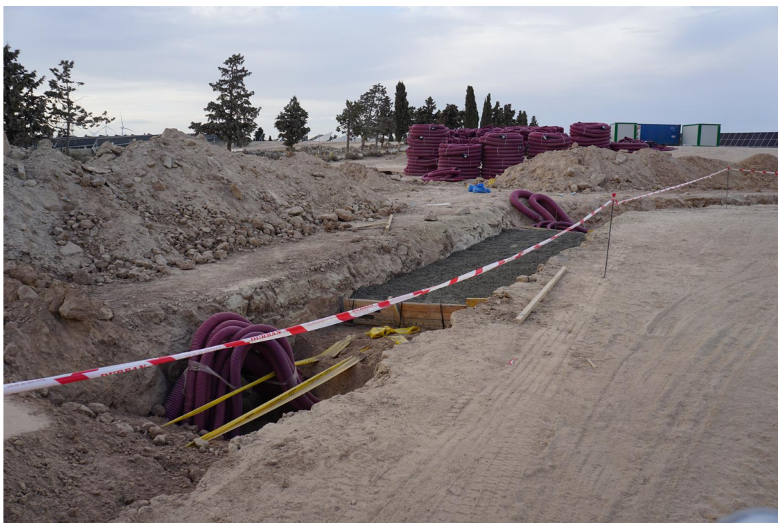
Figura 2a Encofrado de hormigón en zanja en Plana de la Pena 2
