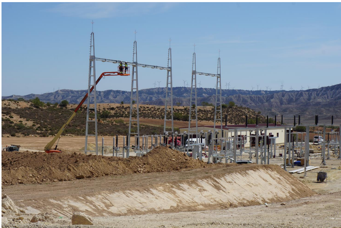
Figura 2b Trabajos de montaje eléctrico en subestación "Vallobar"
