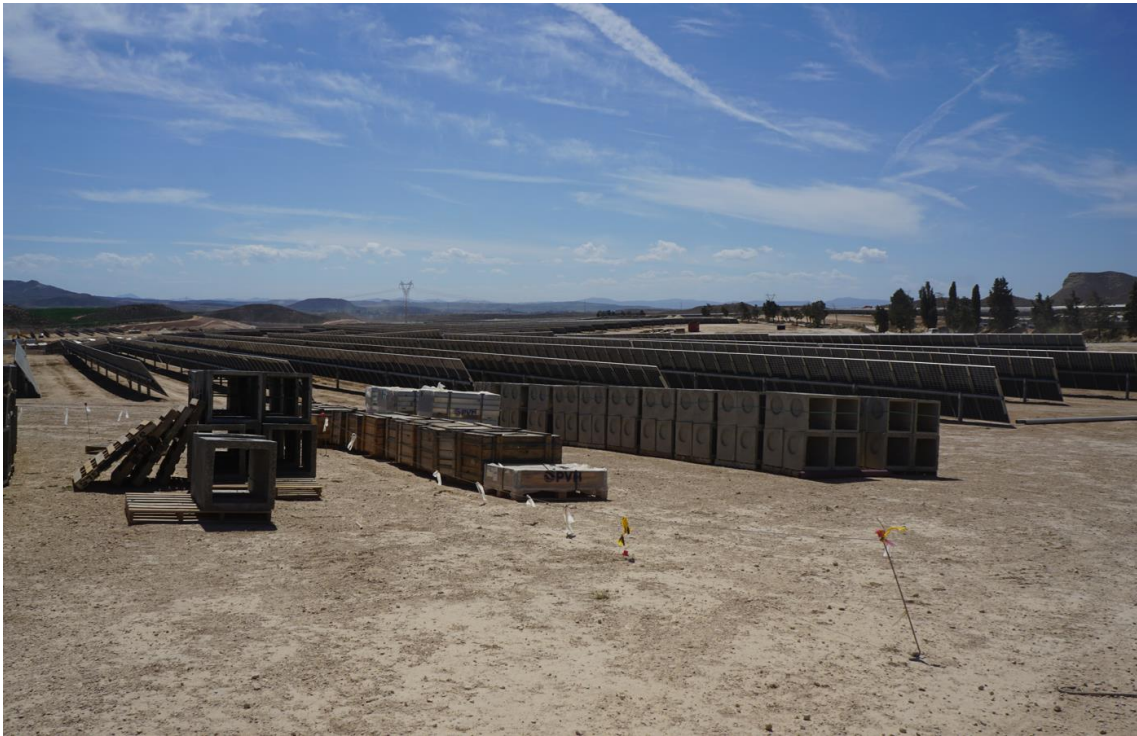
Figura 6 Acopio de arquetas para red eléctrica soterrada
