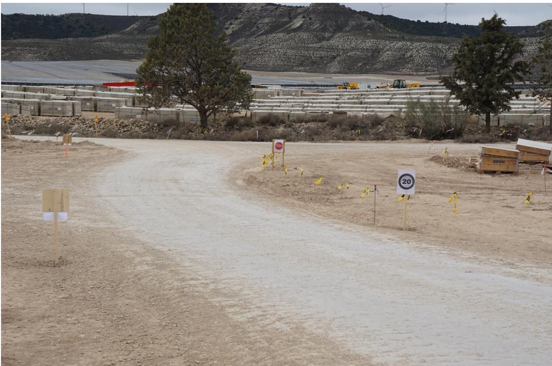
*Figura 10 Señalización de límite de velocidad en obra*
