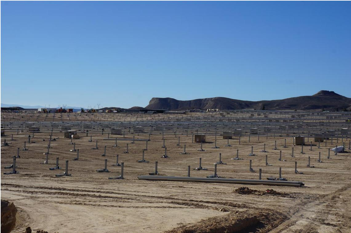
*Figura 5 Instalación de seguidores*
