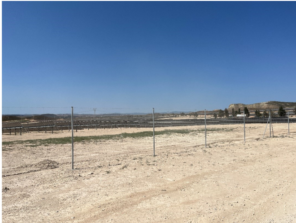
Figura 4 Vallado perimetral sin placas esteparias
