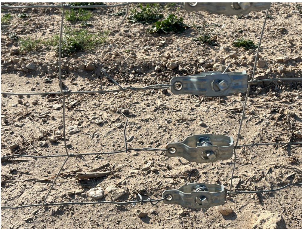
Figura 8 Elementos punzantes en el vallado perimetral
