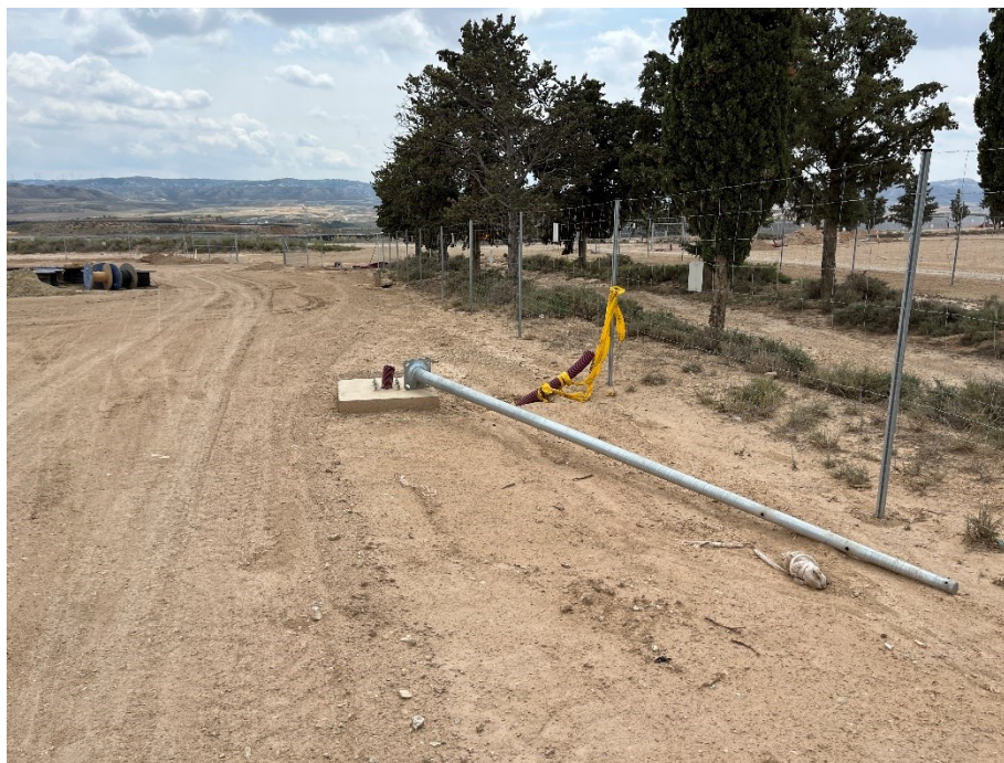
Figura 5 Montaje de los CCTV
