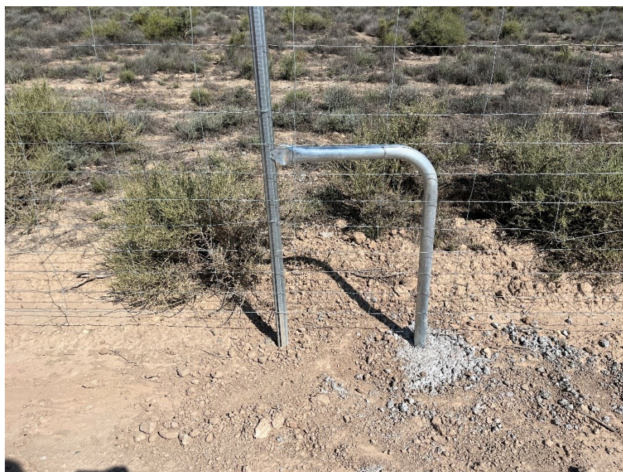
Figura 6 Paso de fauna sin abrir
