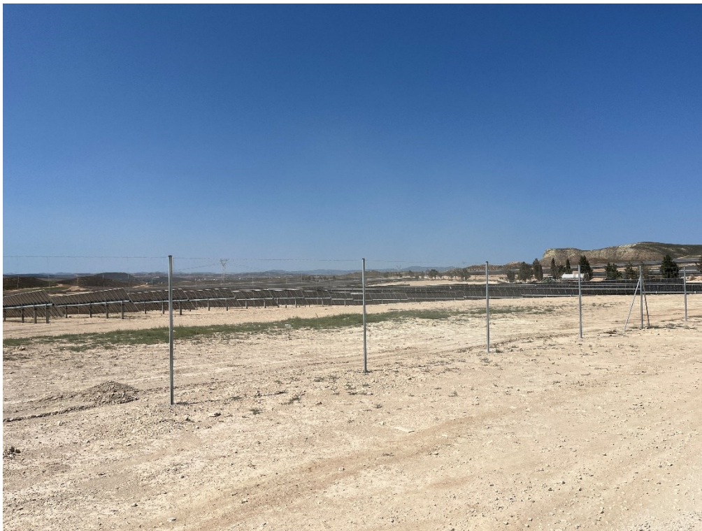
Figura 7 Vallado perimetral sin placas esteparias
