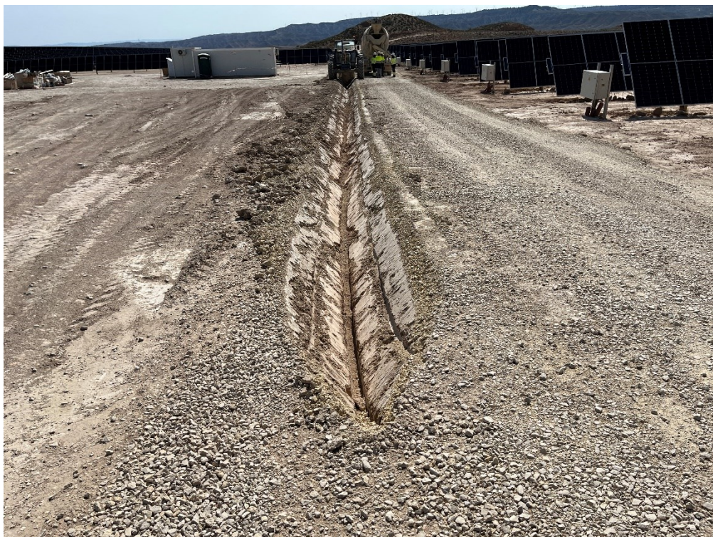
Figura 2 Cimentación de las cunetas
