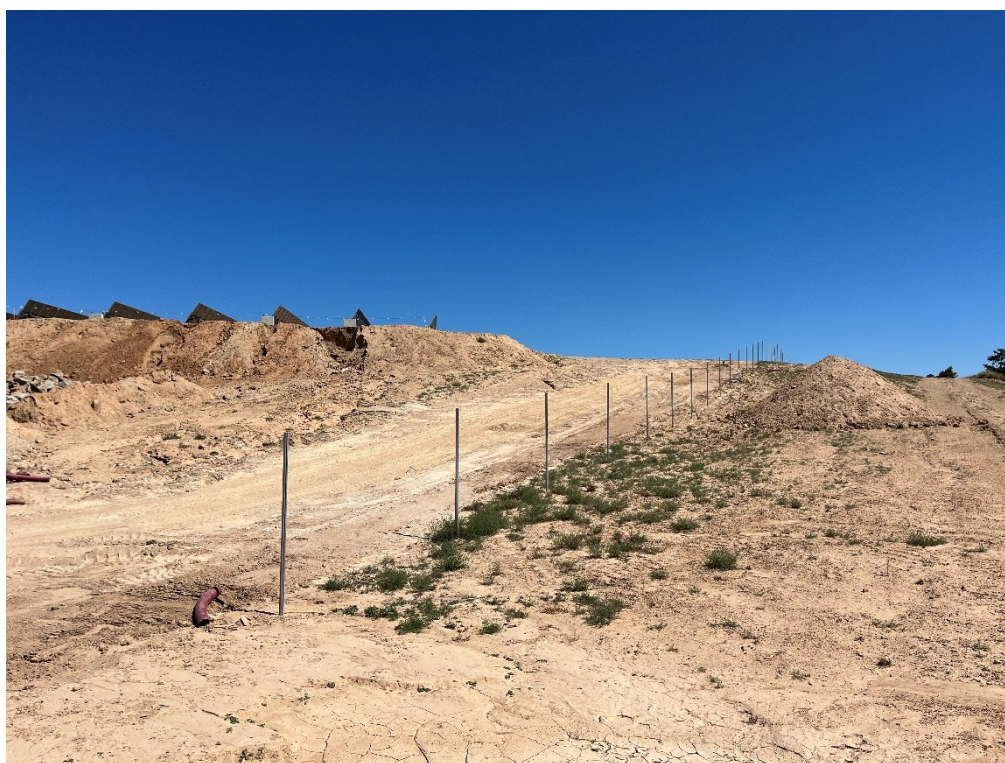
Figura 5 Vallado perimetral sin placas esteparias
