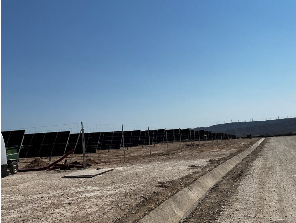
Figura 7 Cimentación de las cunetas
