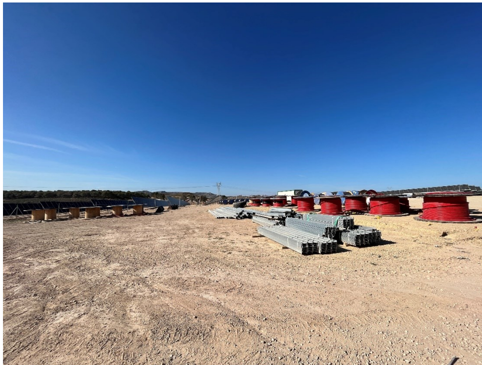
Figura 6 Acopio del material de construcción
