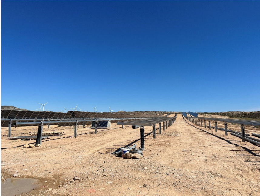
Figura 3 Montaje de los módulos
