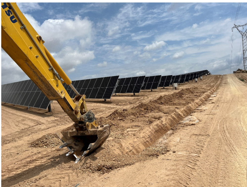
Figura 2 Apertura de las cunetas
