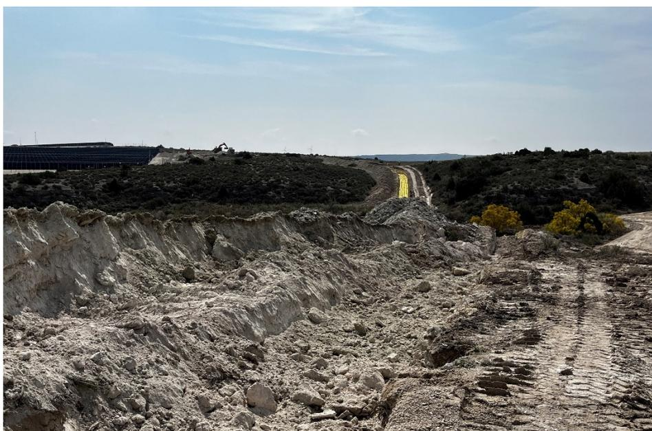
*Figura 11 Cierre de la zanja de evacuación*
