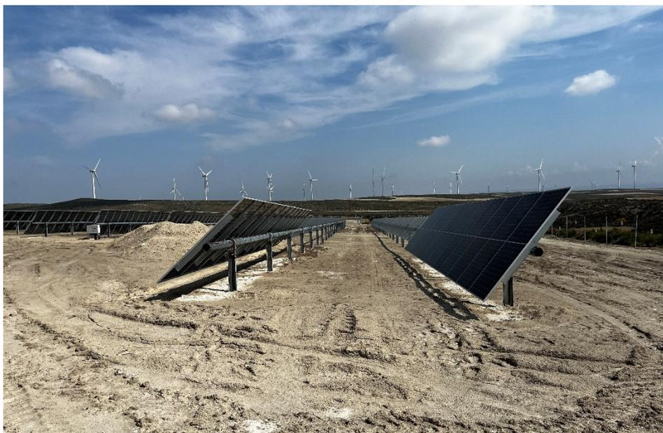
*Figura 10 Montaje de los módulos*
