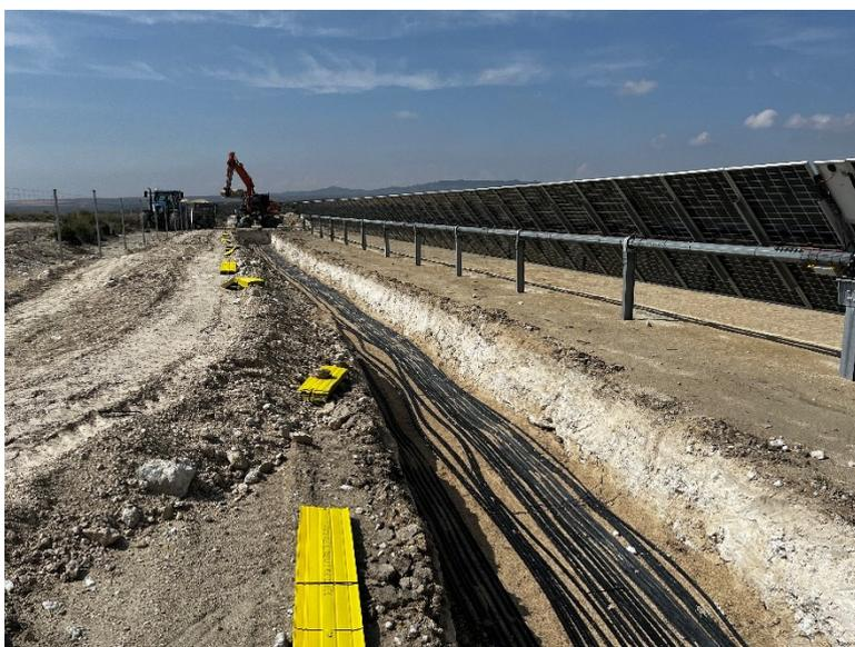
*Figura 2 Cableado de la evacuación de la planta*
