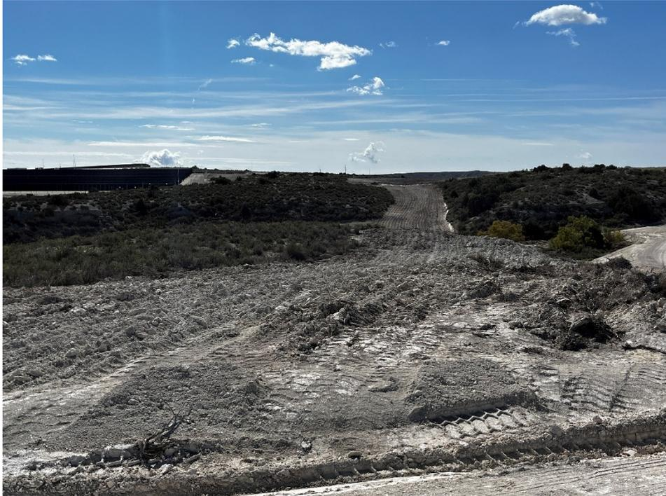
*Figura 12 Cierre de la zanja de evacuación*
