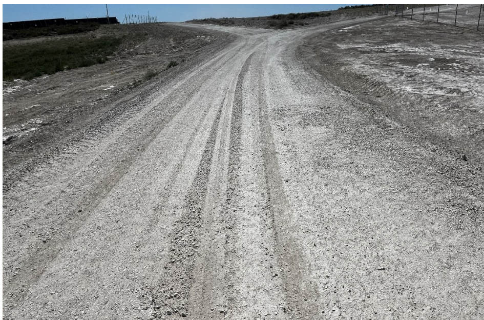
Figura 6 Restauración de los viales
