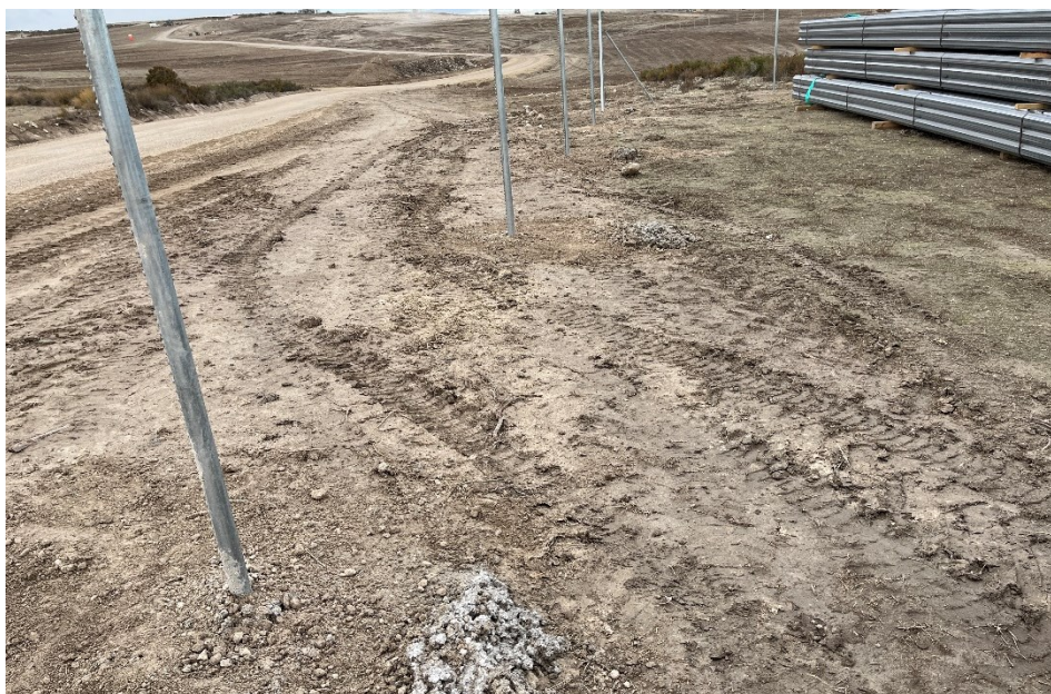
Figura 6 Instalación de los postes del vallado perimetral
