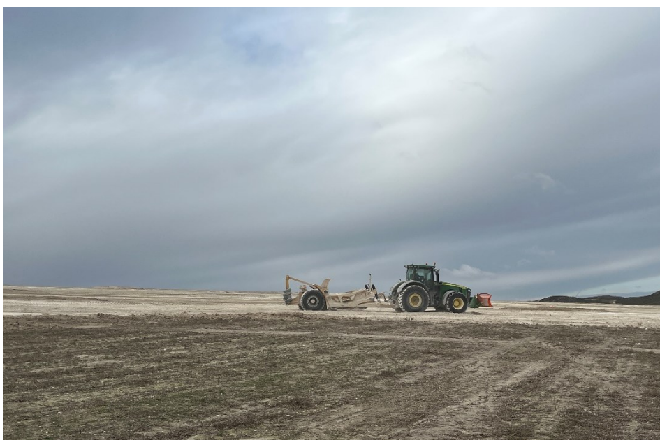
Figura 7 Movimientos de tierras y nivelación del terreno
