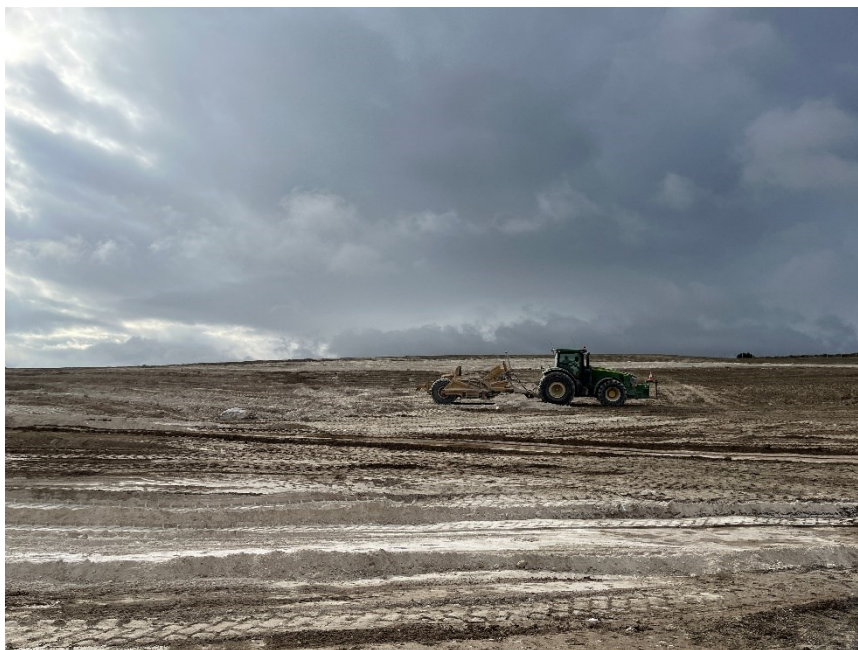
Figura 2 Trabajos de movimientos de tierras y nivelaciones del terreno
