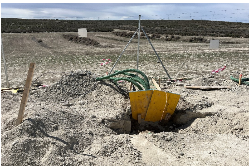
Figura 8 Cimentación de la base de los CCTV
