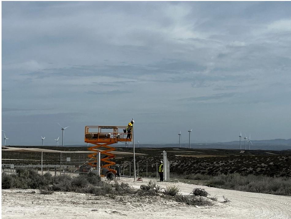
Figura 11 Montaje de los CCTV
