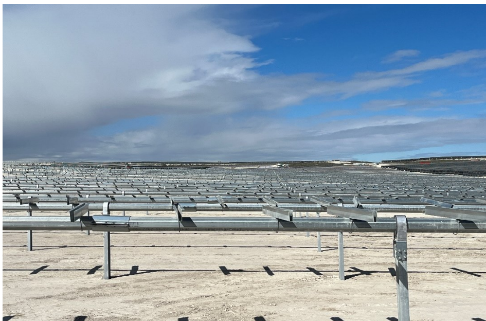
Figura 7 Montaje de los trackers
