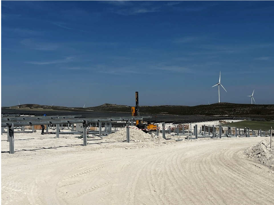
Figura 9 Hincado de la estructura
