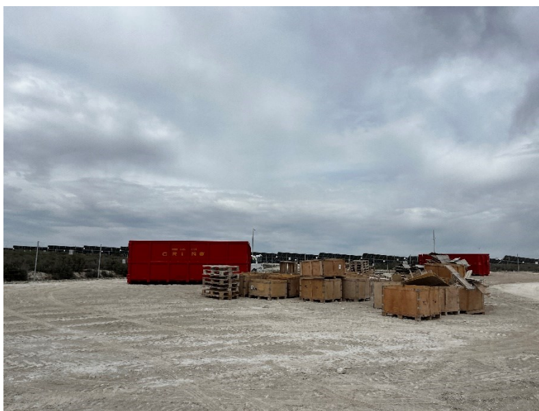
Figura 3 Punto limpio de residuos no peligrosos dispuesto dentro de la planta
