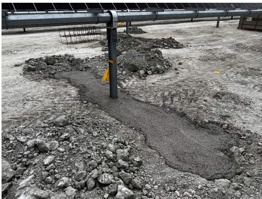
Figura 2 Cimentación de las hincas rechazadas
