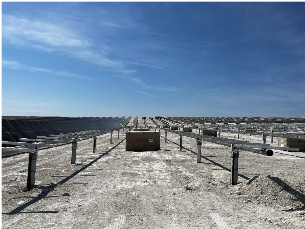
Figura 10 Montaje de los módulos
