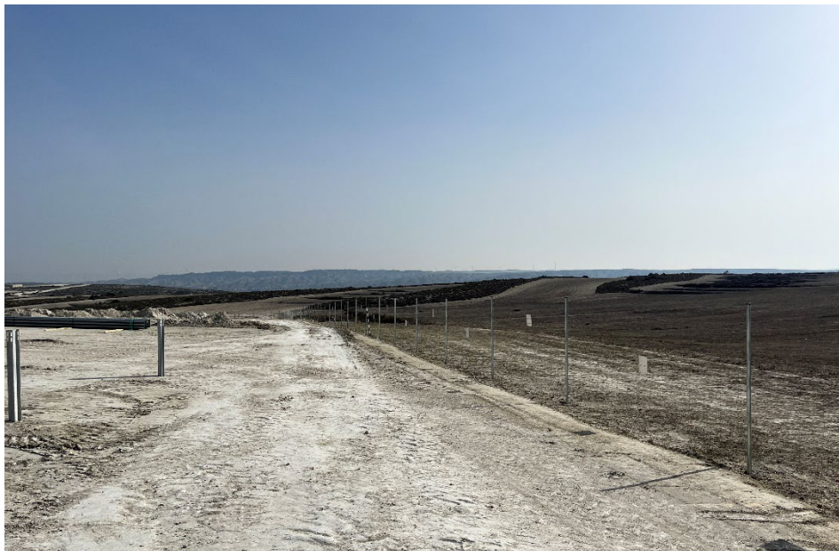
Figura 7 Colocación del vallado perimetral
