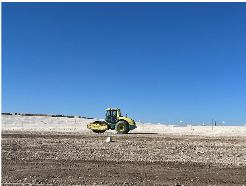
Figura 2 Trabajos de movimiento de tierras
