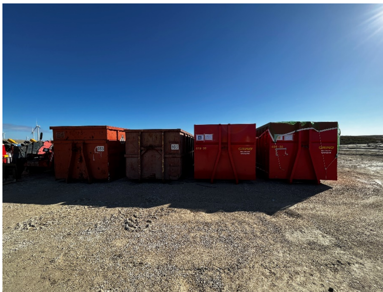
Figura 3 Punto limpio de residuos no peligrosos
