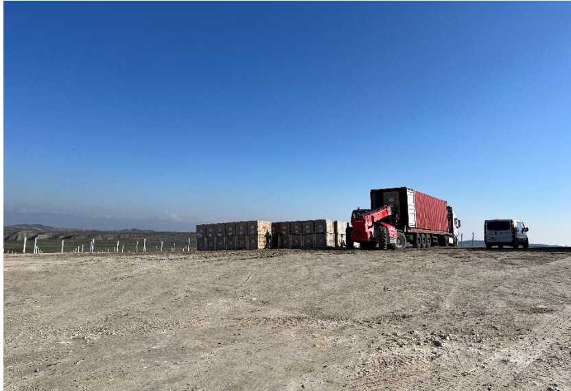
Figura 5 Acopio de material de construcción
