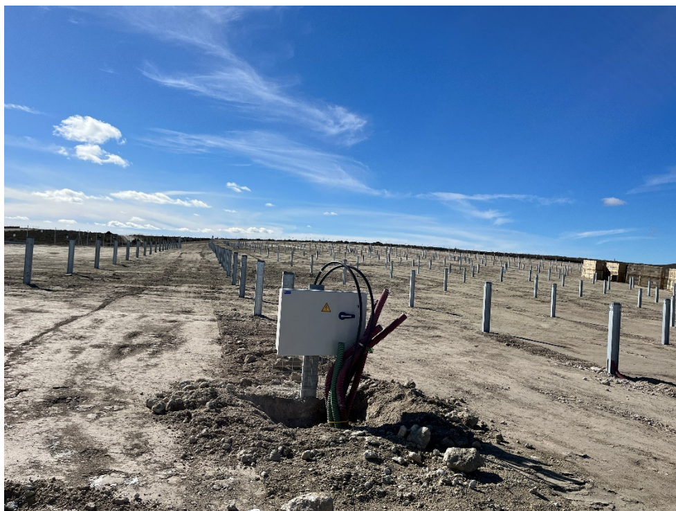
Figura 10 Montaje de los inversores
