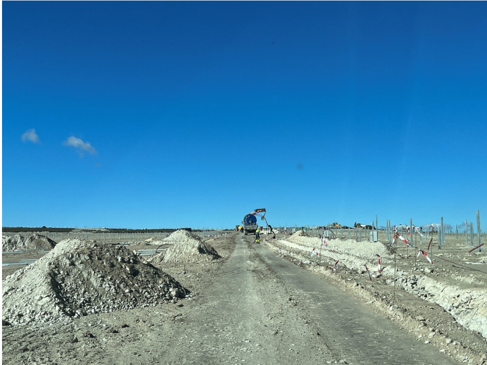
Figura 9 Cableado de las zanjas
