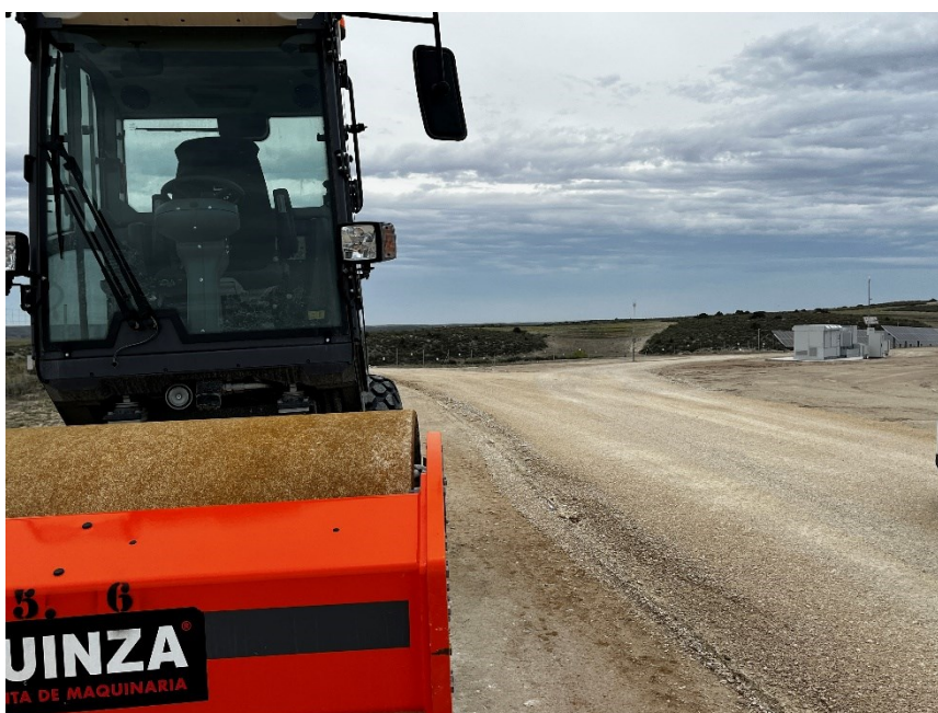
Figura 2 Restauración de los viales
