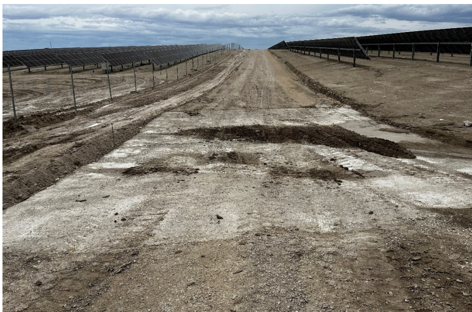
Figura 8 Cimentación del vial interno
