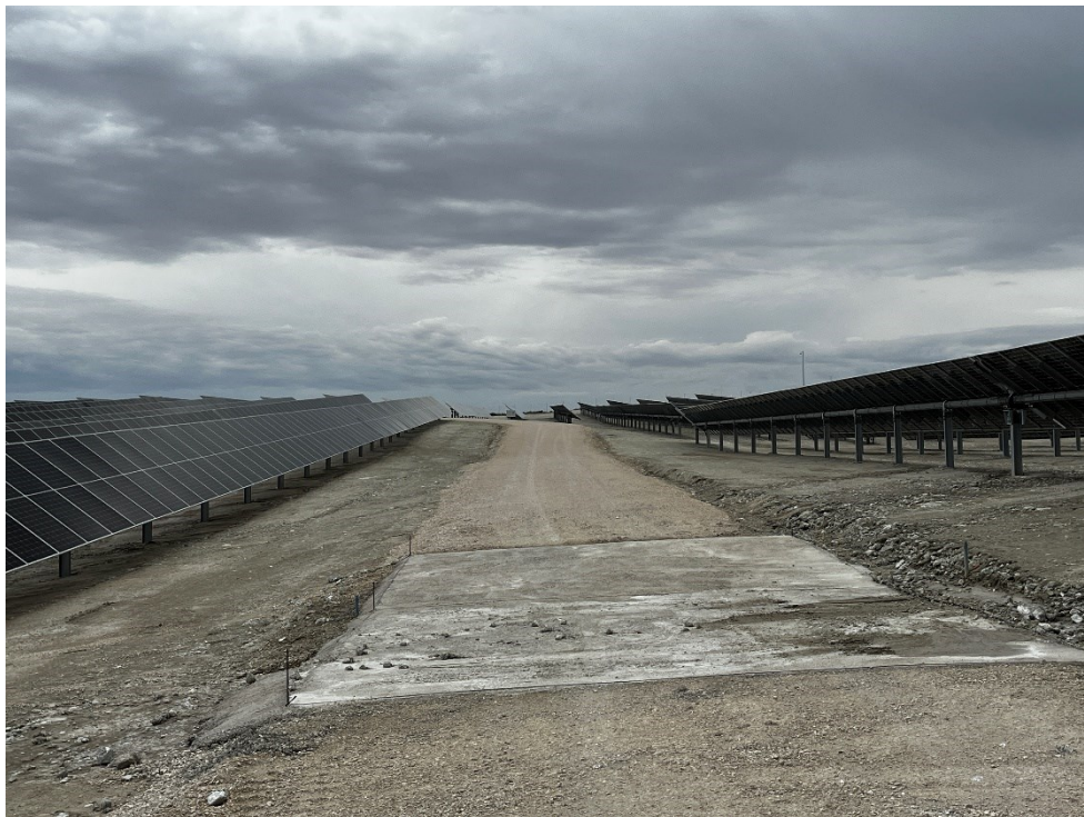
Figura 11 Cimentación del vial interno
