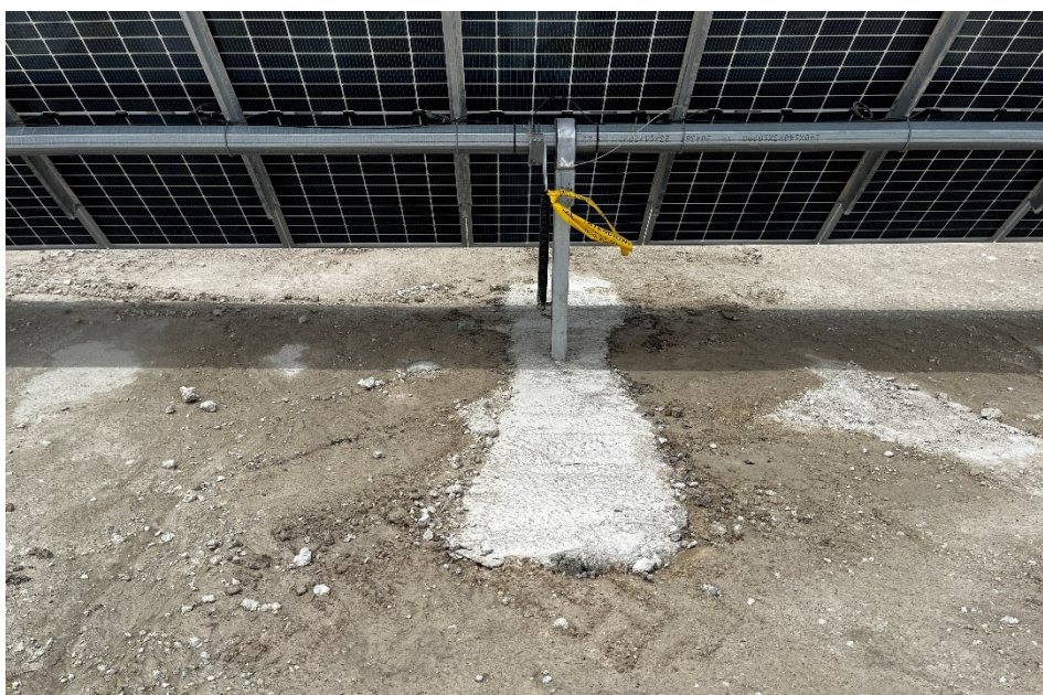
Figura 9 Cimentación de las hincas rechazadas
