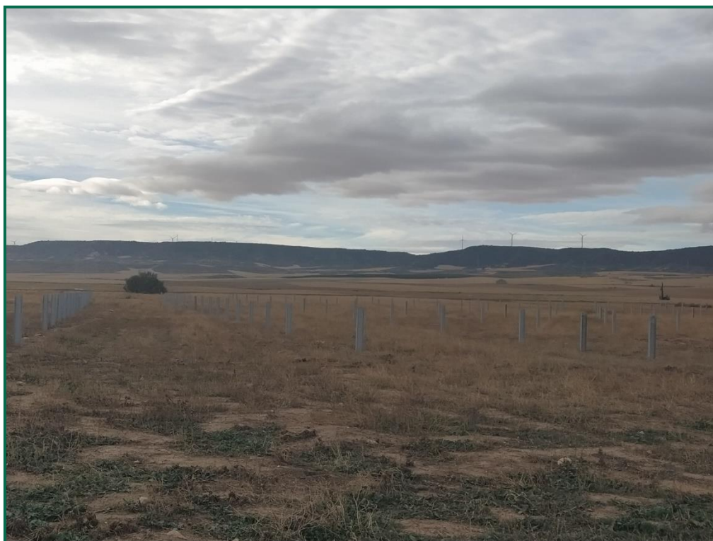
Fotografía 5. Hincas sobre el terreno.
