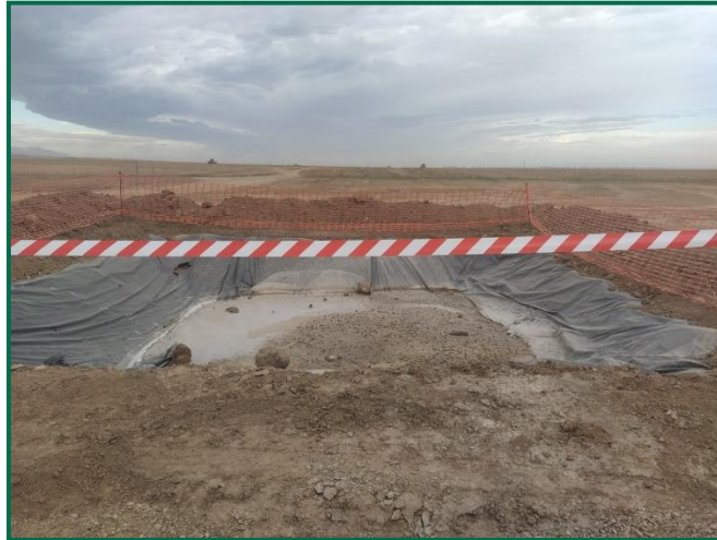
Fotografía 8. Zona de lavado de hormigón.
