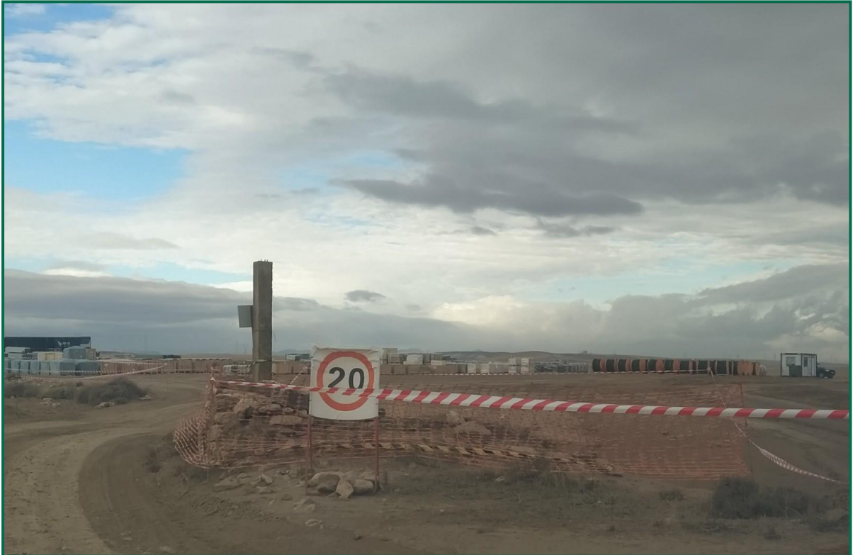
Fotografía 2. Señal de limitación de velocidad.
