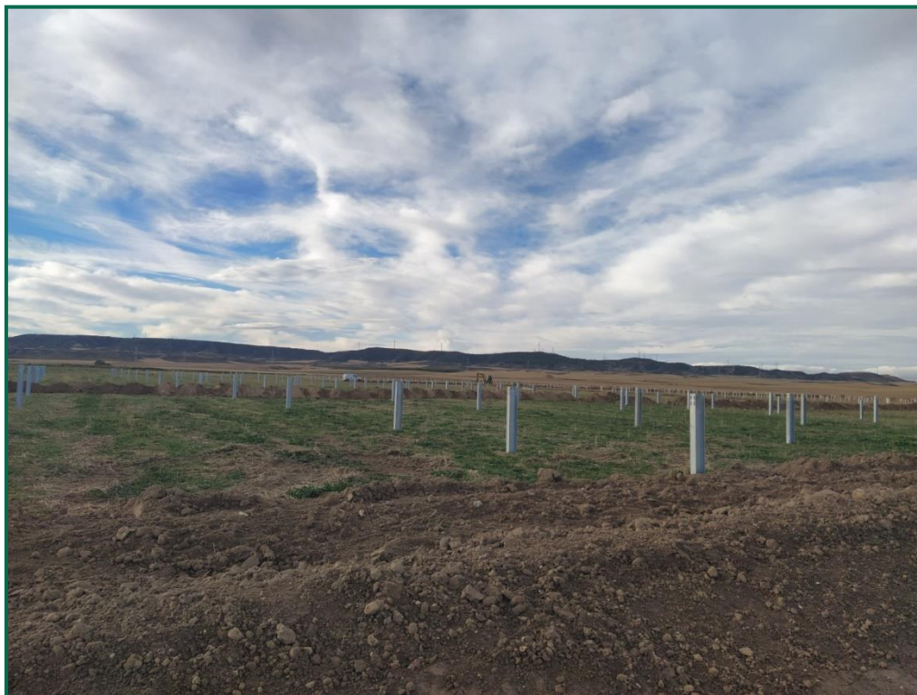
Fotografía 4. Hincas sobre el terreno.
