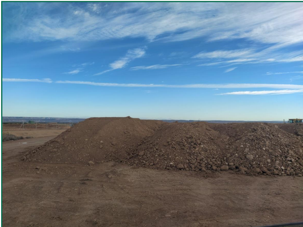
Fotografía 3. Acopio de tierra.
