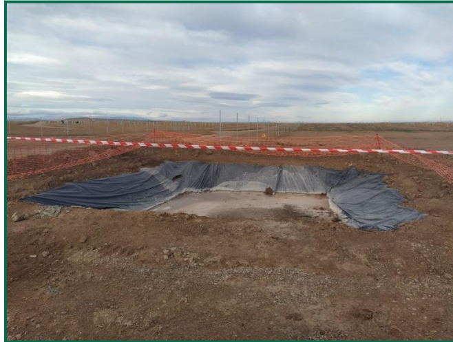
Fotografía 6. Zona de lavado de hormigón.
