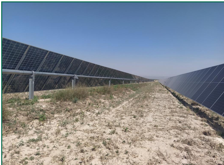
Fotografía 6. Hincas sobre el terreno.
