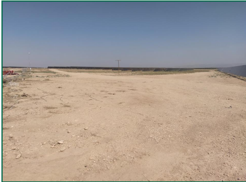
Fotografía 11. Zona de lavado de hormigón, ya eliminada.
