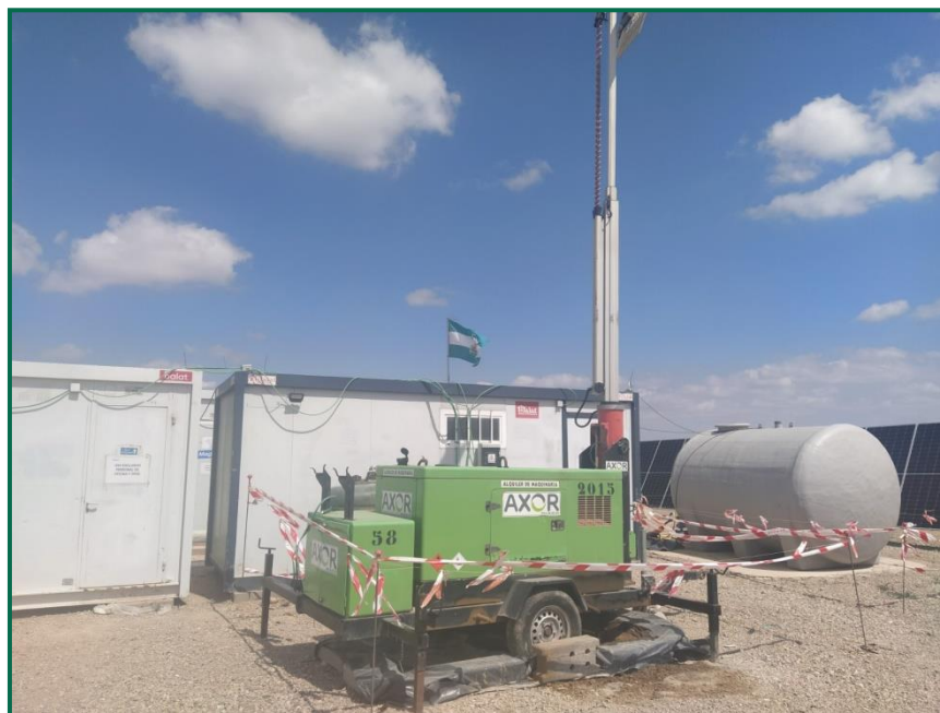
Fotografía 9. Grupo electrógeno.
