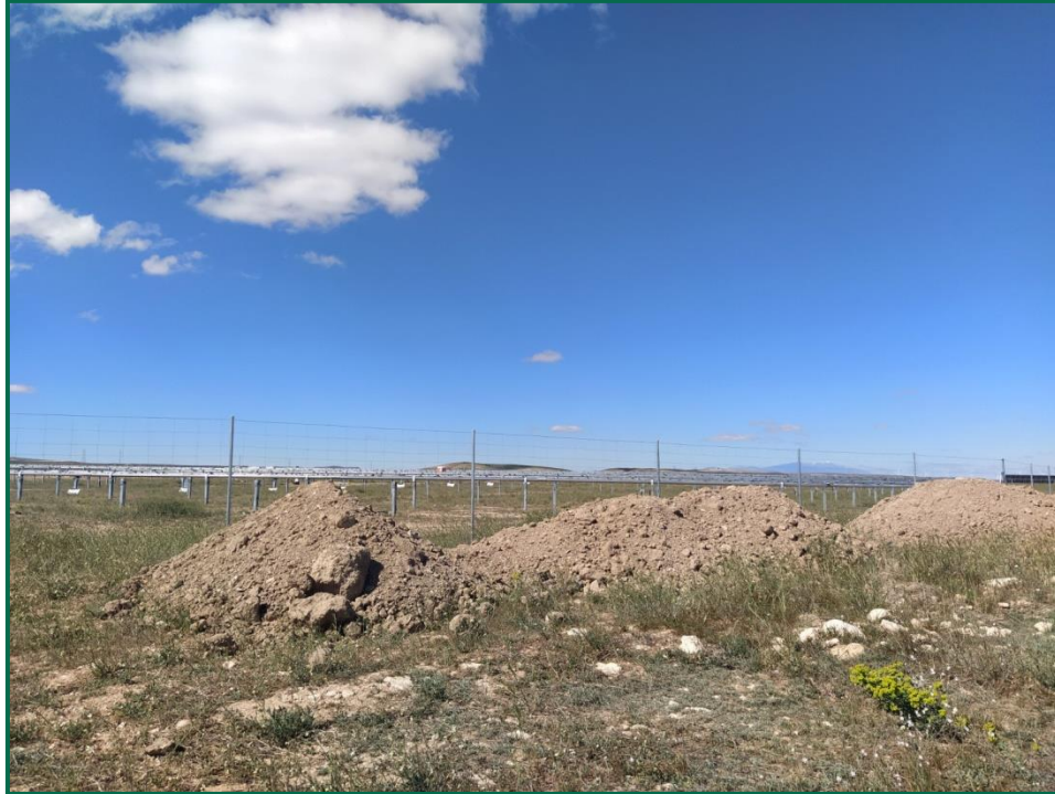
Fotografía 4. Acopio de tierra.
