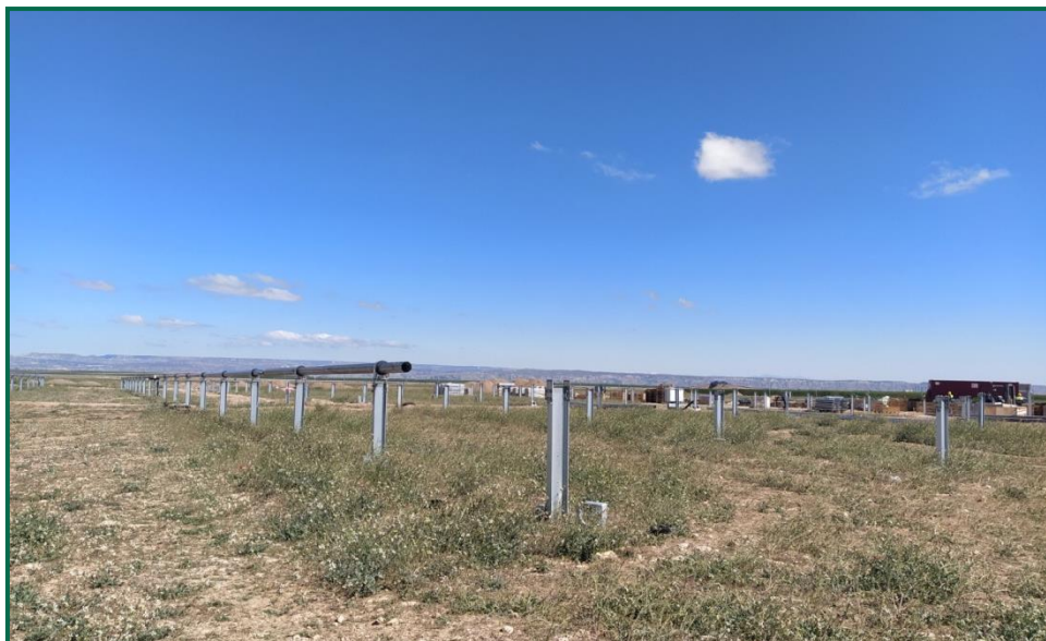
Fotografía 5. Hincas sobre el terreno.
