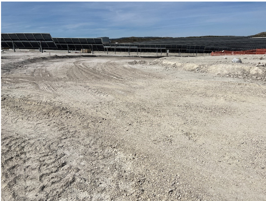
Figura 9 Apertura del vial interno
