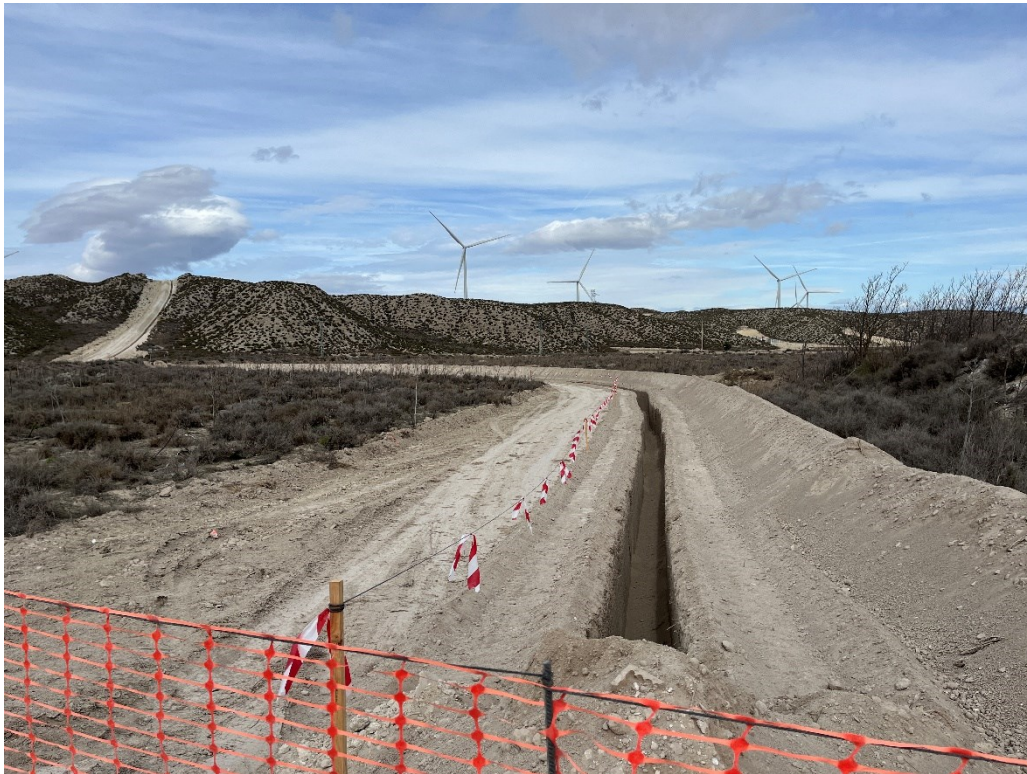
Figura 10 Zanja de la red de evacuación
