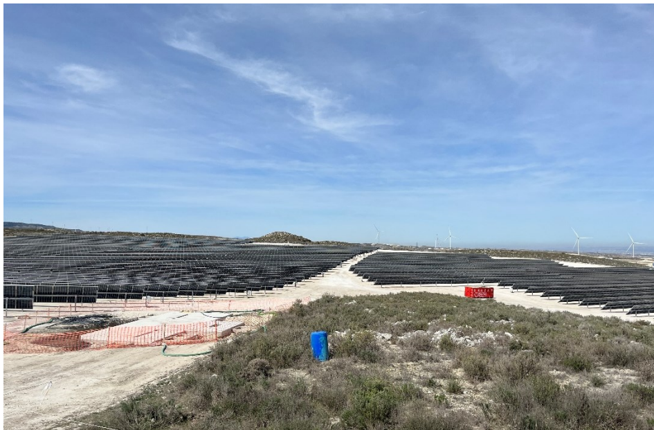
Figura 6 Montaje de los módulos fotovoltaicos
