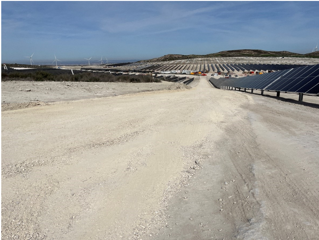
Figura 8 Apertura del vial interno
