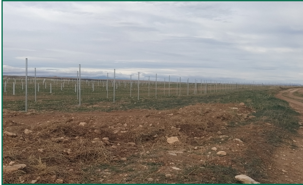
Fotografía 4. Acopio de tierra.
