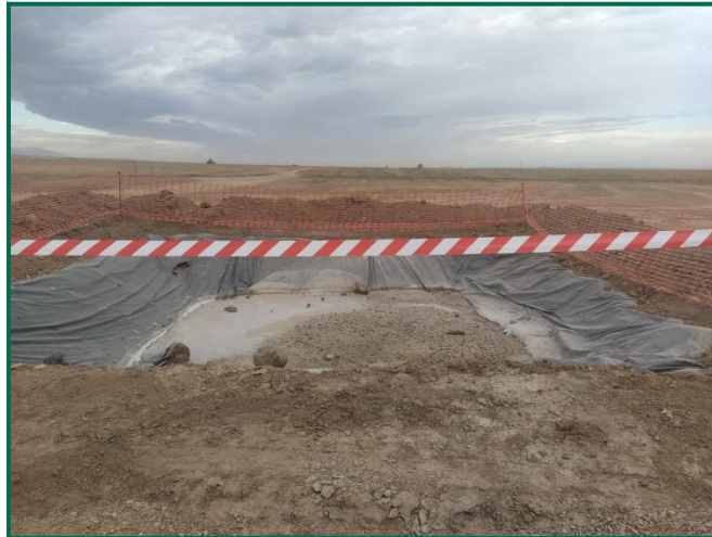
Fotografía 8. Zona de lavado de hormigón.
