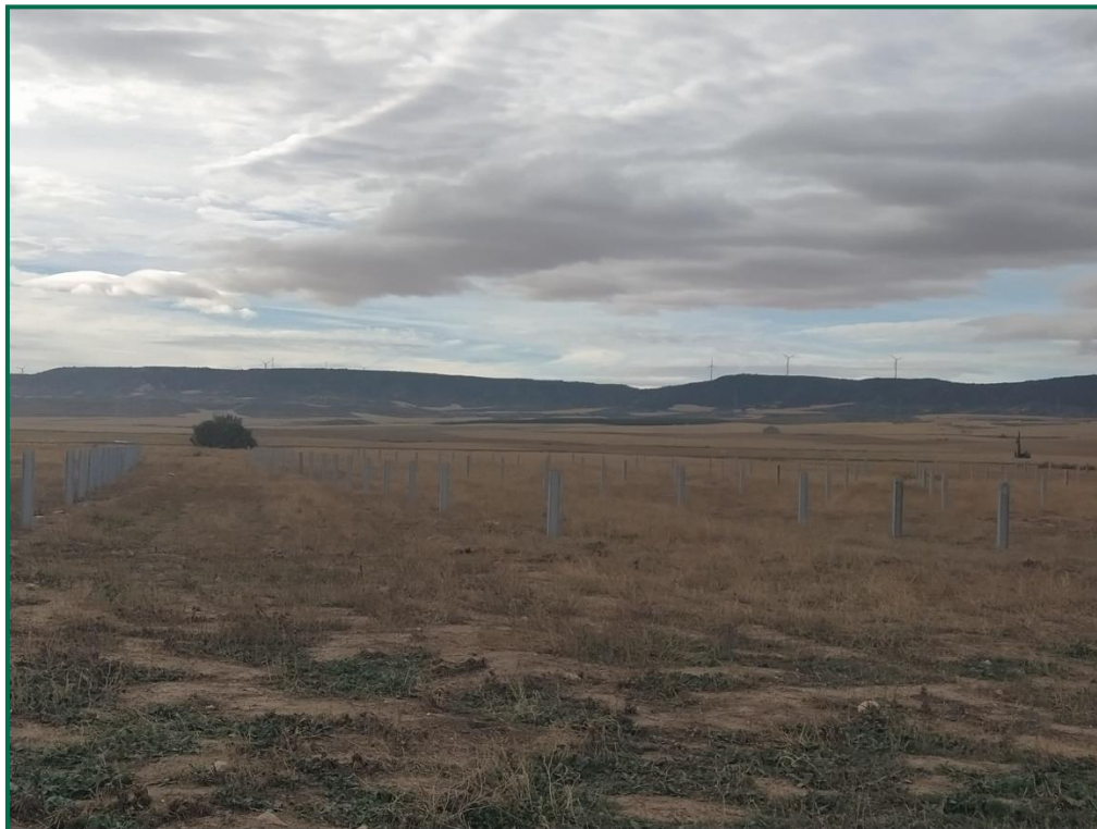
Fotografía 5. Hincas sobre el terreno.
