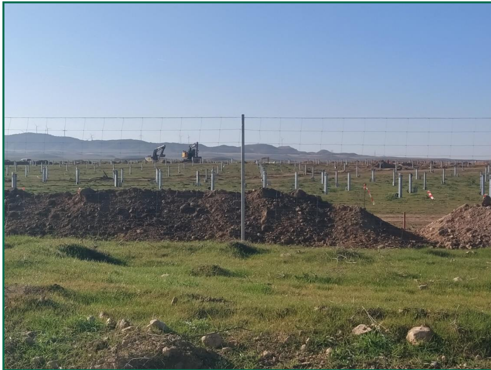
Fotografía 3. Acopio de tierra e hincas sobre el terreno.
