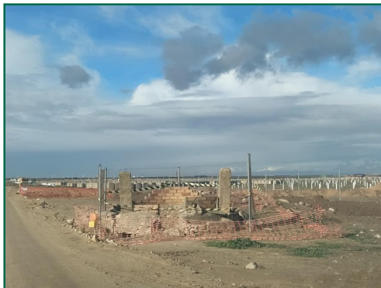
Fotografía 10. Muella de carga
