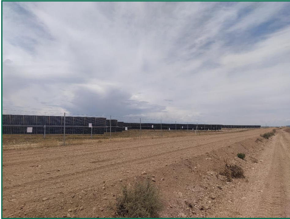
Fotografía 4. Acopio de tierra ya extendida.
