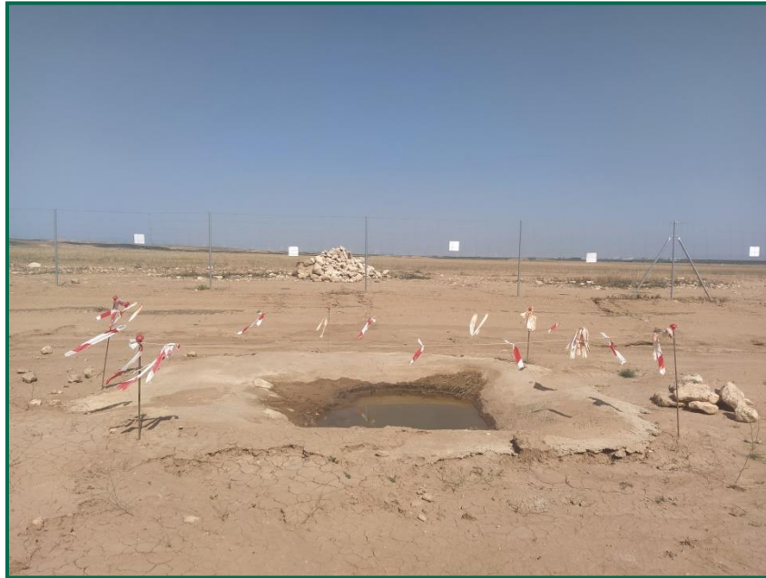
Fotografía 7. Balsete ya construido.
