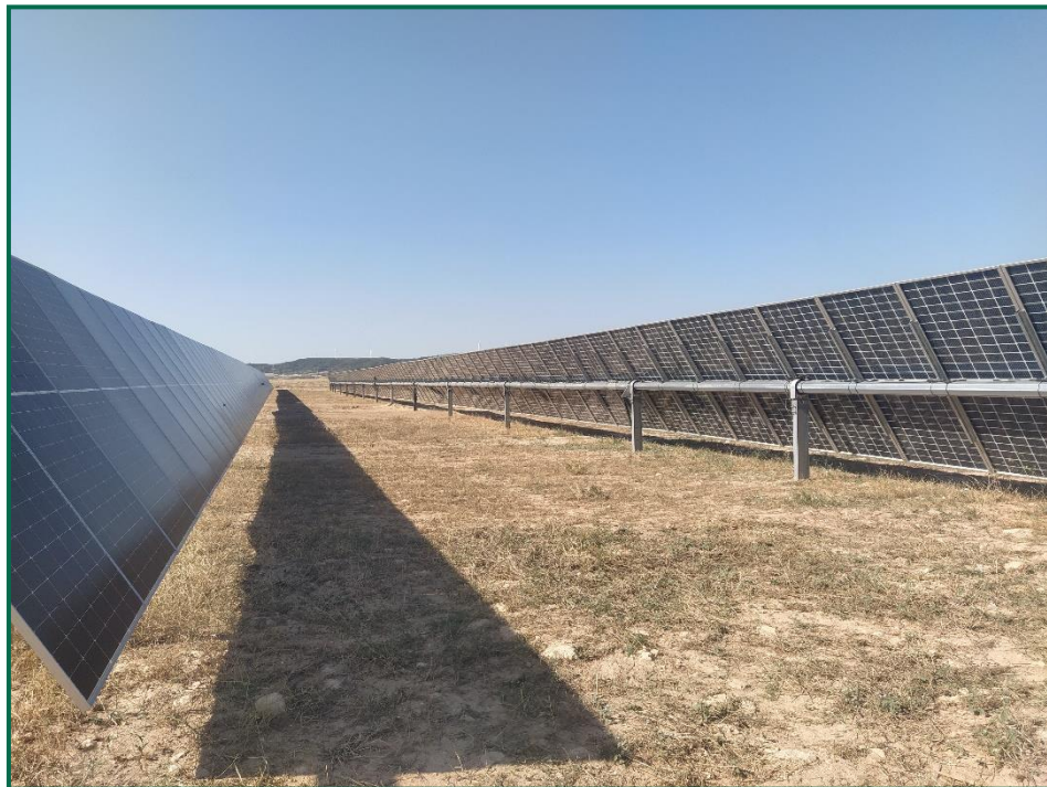
Fotografía 5. Hincas sobre el terreno.
