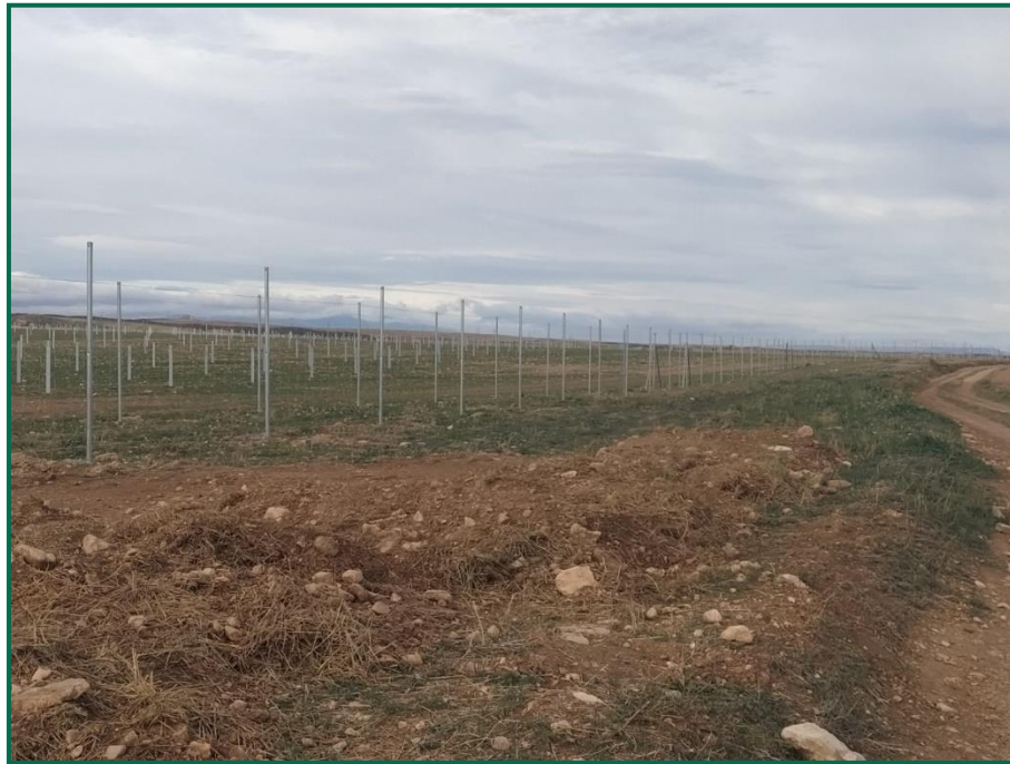
Fotografía 3. Acopio de tierra.
