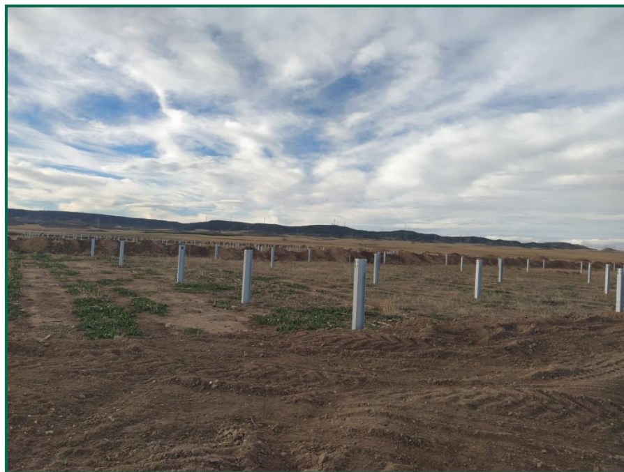
Fotografía 4. Hincas sobre el terreno.
