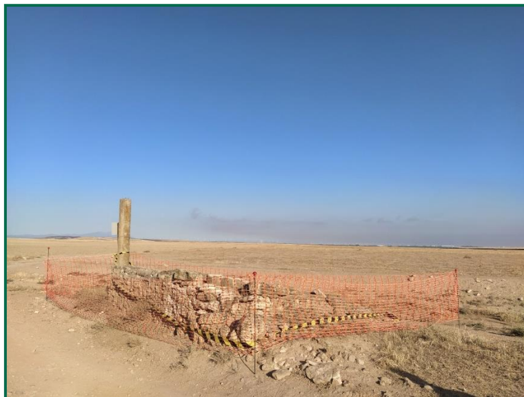
Fotografía 12. Muella de carga
