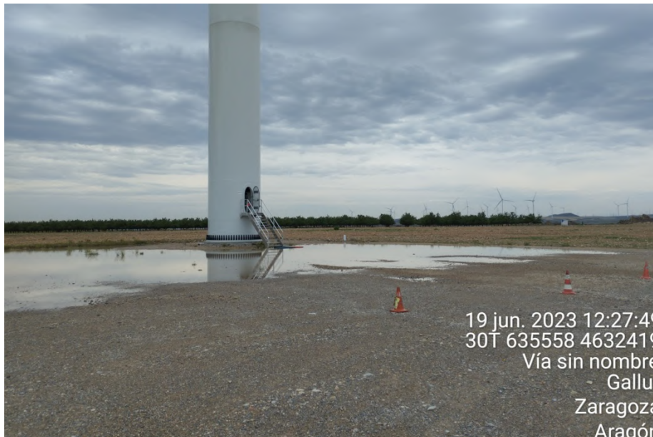
Figura 25: Fotografía del 19 de junio de 2023 mostrando la plataforma de MU-03 parcialmente inundada. El balizamiento de conos que se observa en la imagen no se corresponde a la inundación sino a unas labores de mantenimiento del aerogenerador.
