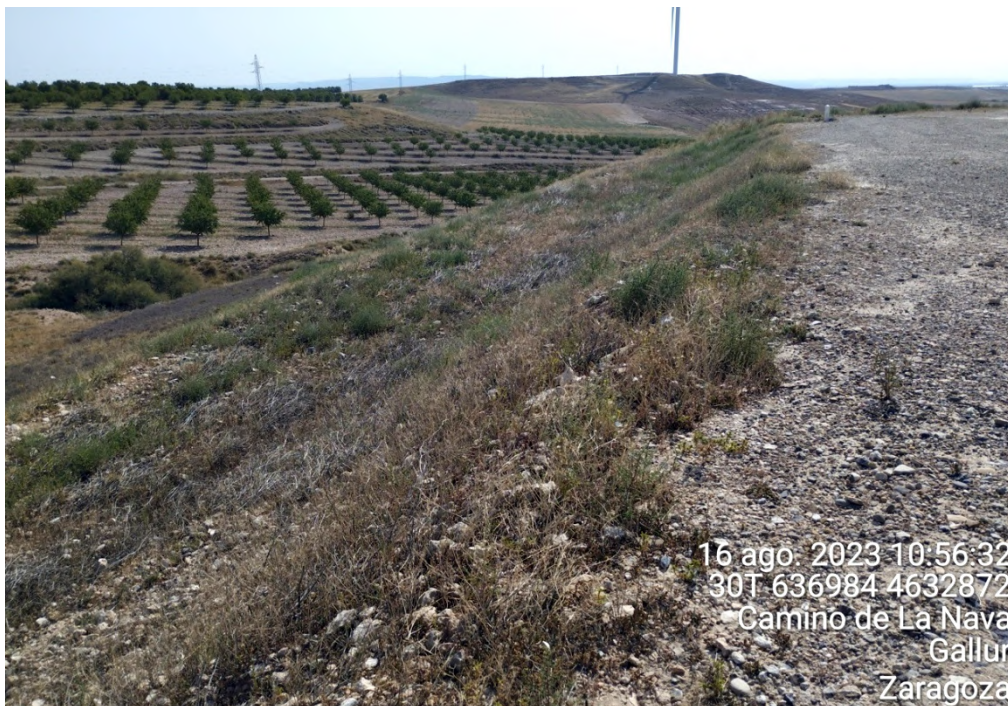
Figura 32: Talud de la colina de la plataforma de MU-07, en correcto estado de conservación y restauración.
