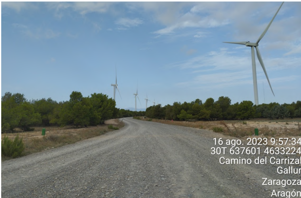
Figura 29: Vial de acceso a la altura de aerogenerador MU-08, cruzando pinar de repoblación.
