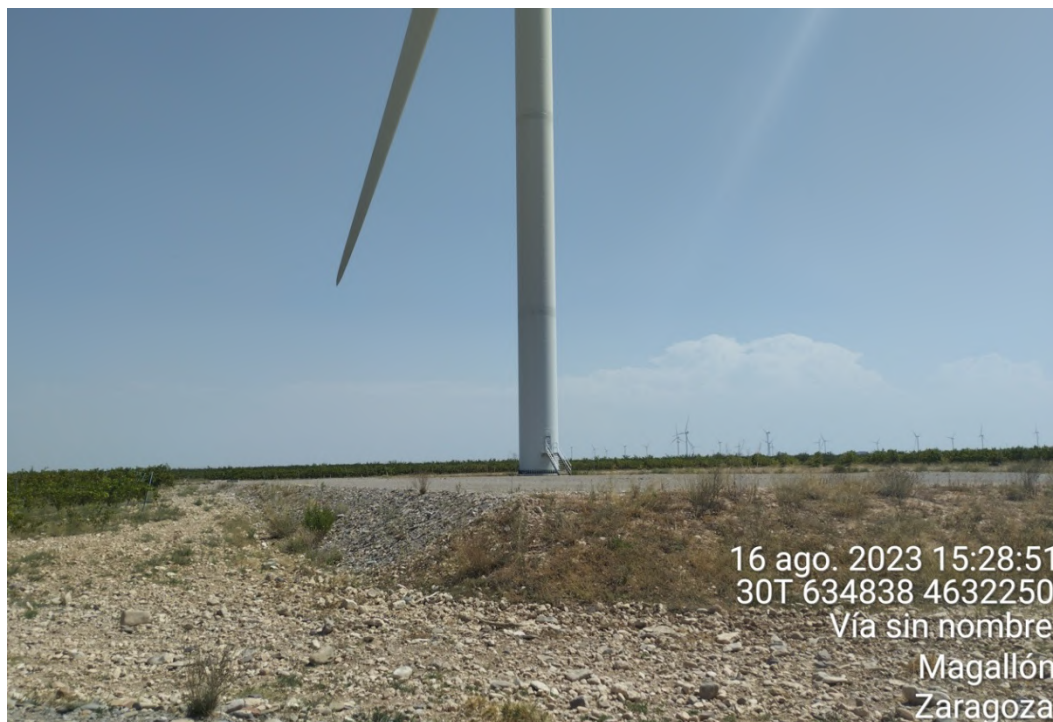
Figura 36: Talud de la plataforma del aerogenerador MU-01.
