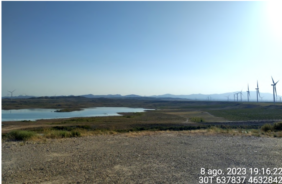
Figura 19: Plano general de la costa oeste del Embalse de la Loteta a agosto de 2023.
