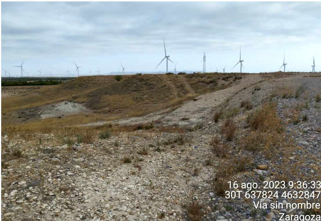
Figura 26: Talud noreste de MU-09, en correcto estado de conservación.
