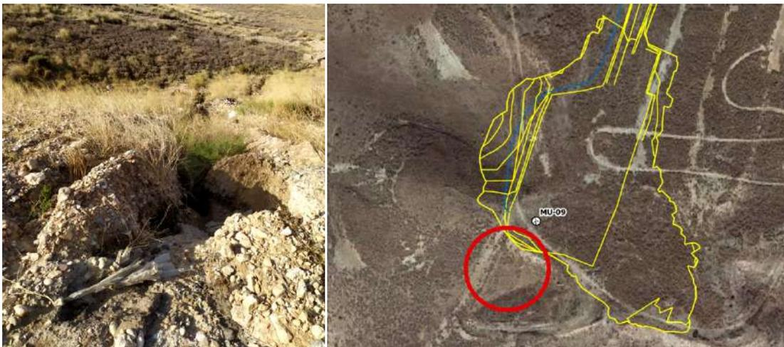
Figura 25: Fotografía y plano de localización de la erosión del talud al sur de la plataforma del aerogenerador MU-09. Pueden observarse varias cárcavas acusadas provocadas por el agua de precipitaciones torrenciales.
