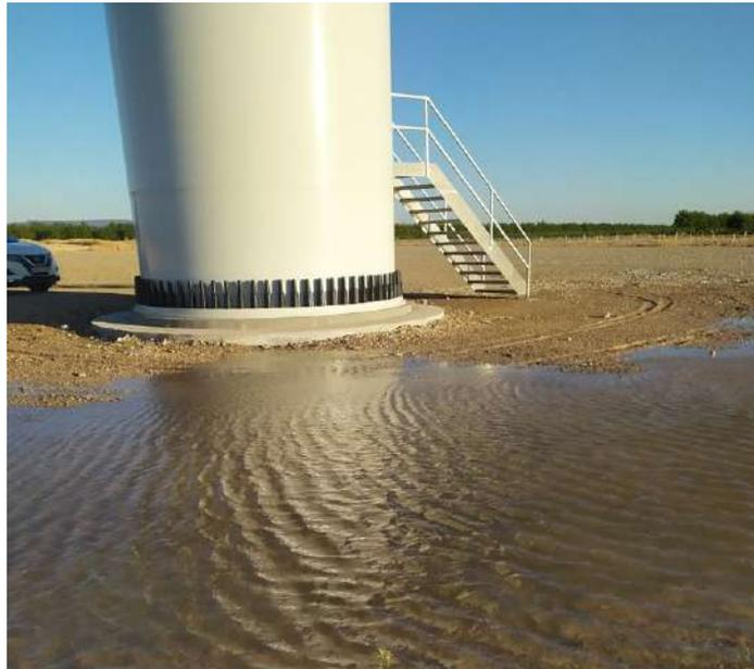
Figura 26: Plataforma de MU-05 parcialmente inundada tras las lluvias. (8 de Julio de 2022).
