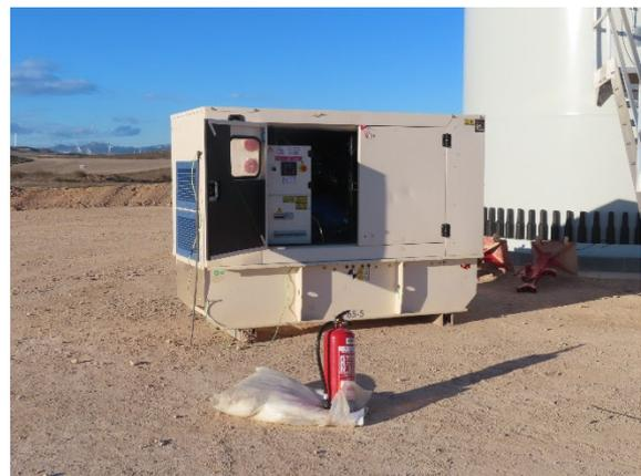
Derrames de productos peligrosos en el suelo en distintos puntos de la obra. Abajo a la derecha, mantas absorbentes distribuidas junto a los grupos electrógenos para evitar nuevos vertidos en las labores de repostaje.
