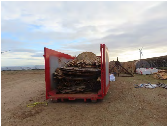
Contenedor de madera habilitado por Cobra fuera de las obras, en recinto vallado de planta fotovoltaica de la propiedad, 4 Km al sur.
