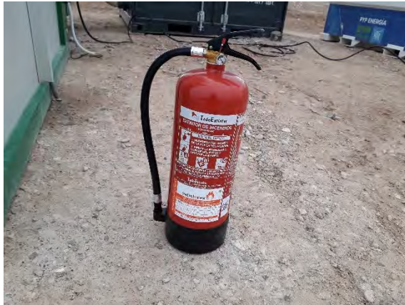
Extintor dispuesto en la obra junto a grupo eléctrico.
