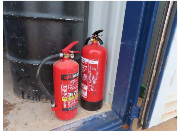
Extintores en punto limpio de Siemens-Gamesa.
