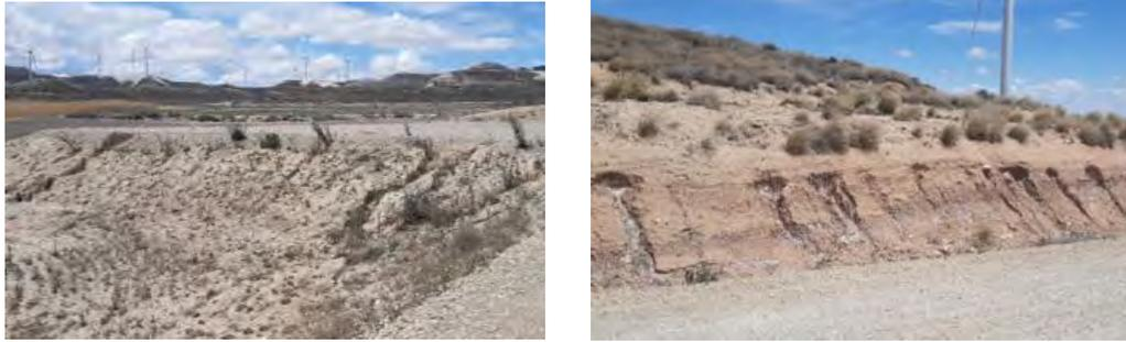
Fig. 1 Erosión hídrica en materiales lutíticos del talud terraplén de plataforma del aero CA.02 y CA-08. Fuente: Elaboración propia
