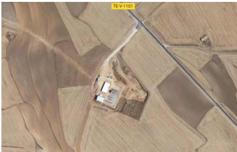
Figura 1: Vistas de la subestación de Venta Vieja
