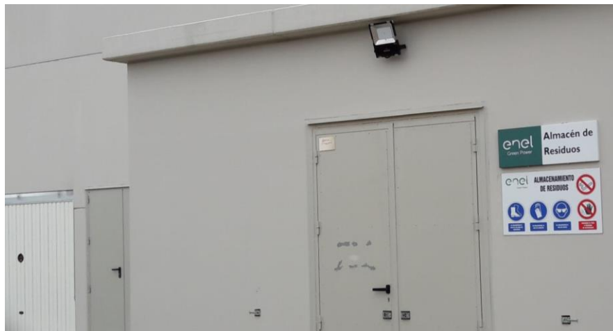
Punto limpio habilitado en la subestación Venta Vieja
