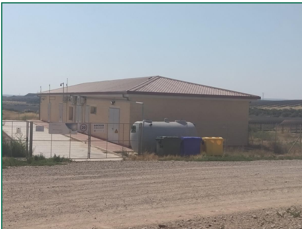
Fotografía 15. Contenedores de residuos no peligrosos en exterior de la subestación.
