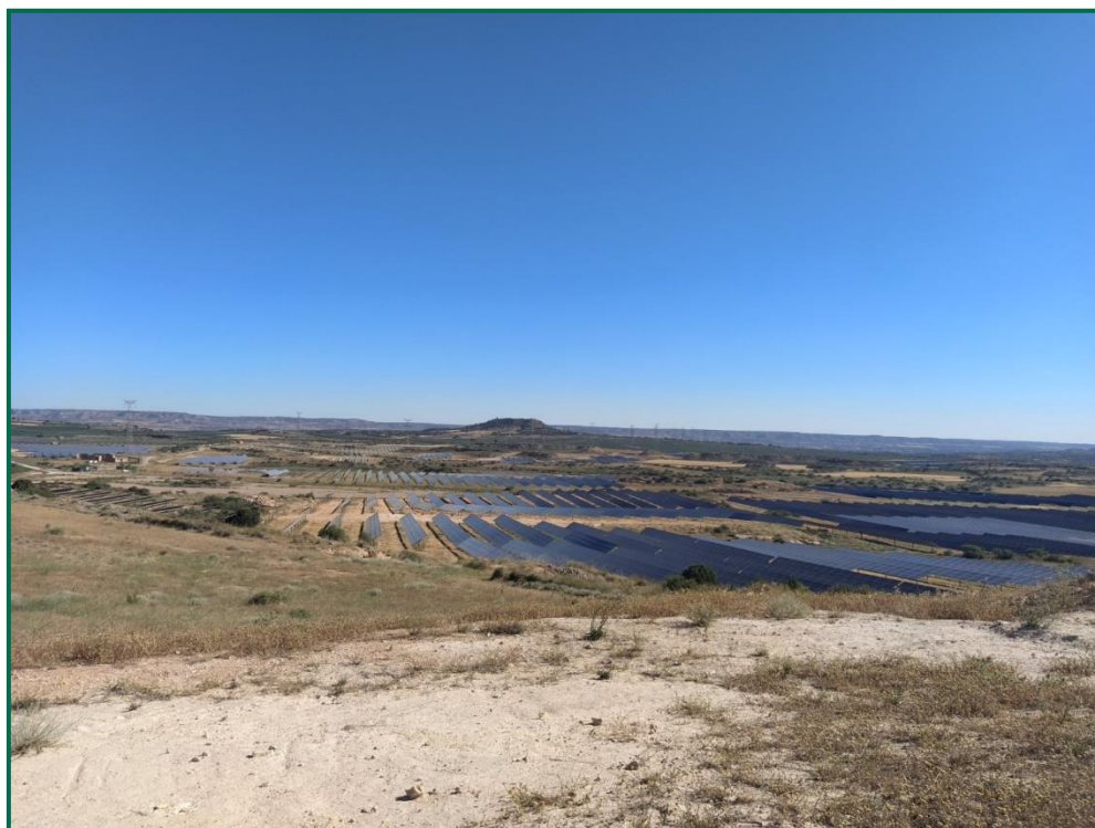
Fotografía 1. Vegetación entre placas actualmente.
